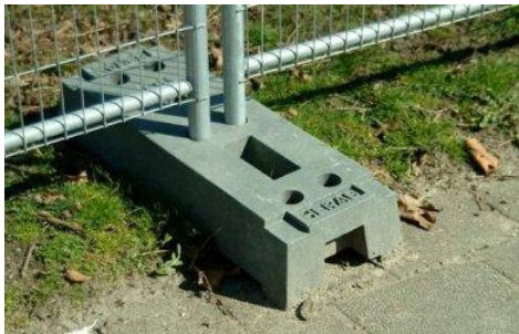
Obr. 31 – Nosná betonová patka [18]
