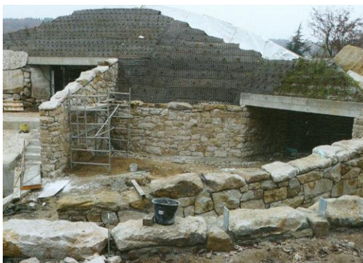
Obr. 15 Obkládání kamenným obkladem [46]
