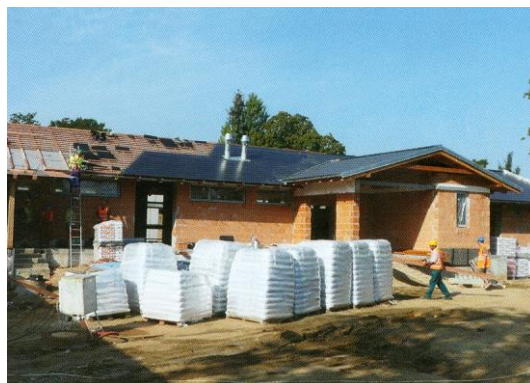
Obr. 16 Pokládání střechy u gazej [41]
