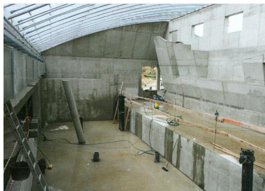
Obr. 10 Hrubá stavba – vnitřní bazén [41]
