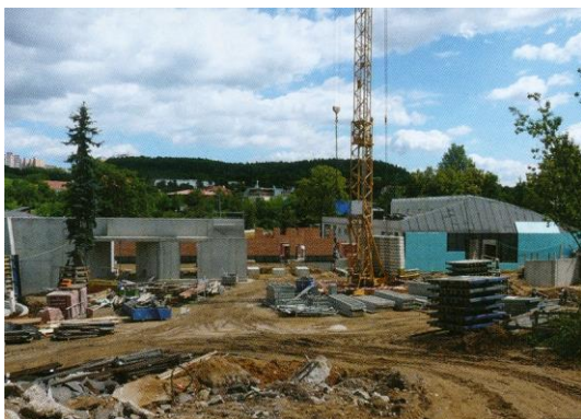
Obr. 9 Výstavba exteriéru pavilonu [46]
