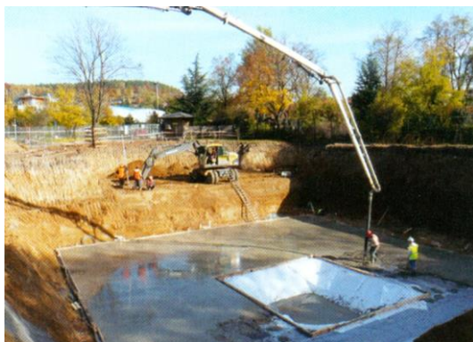
Obr. 4 Betonáž základové desky [41]
