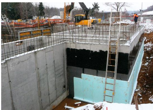
Obr. 5 Suterén – hrubá stavba [46]
