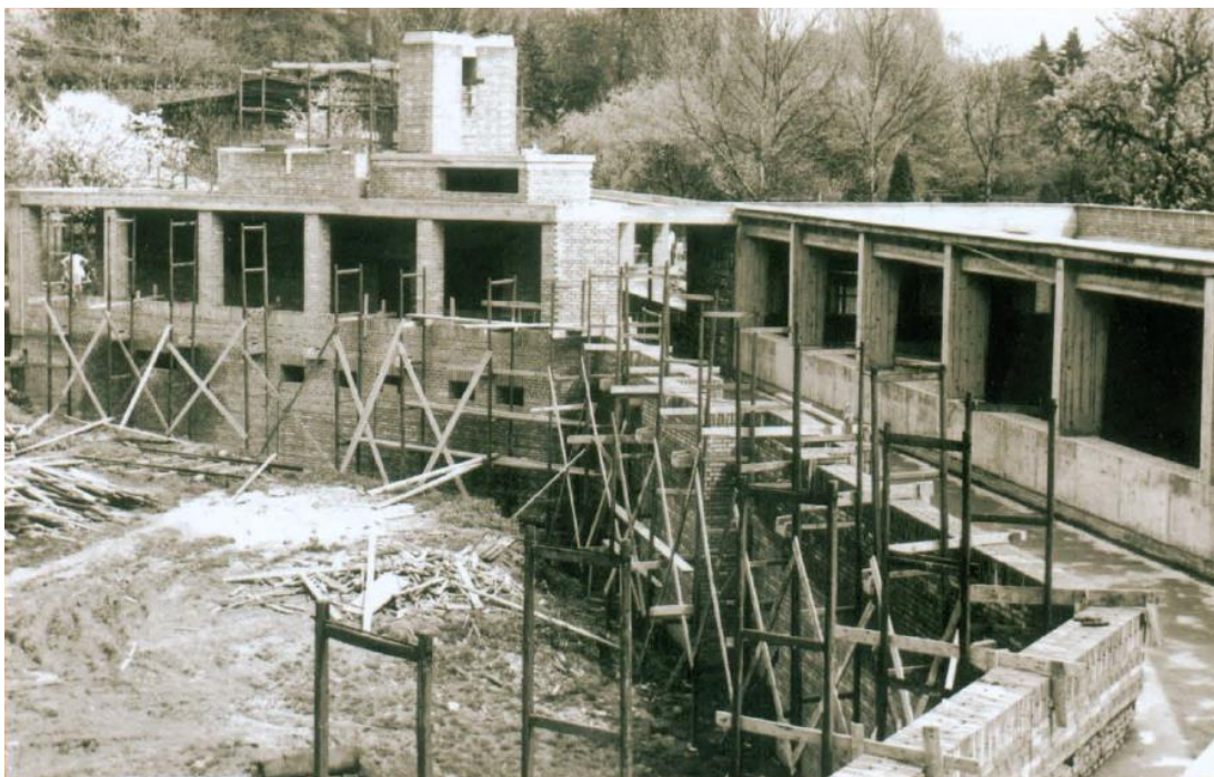
Obr. 2 Výstavba Domu velkých savců [7]
