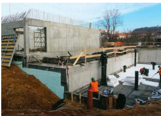
Obr. 7 Nadzemní podlaží – izolace bazénu [46]
