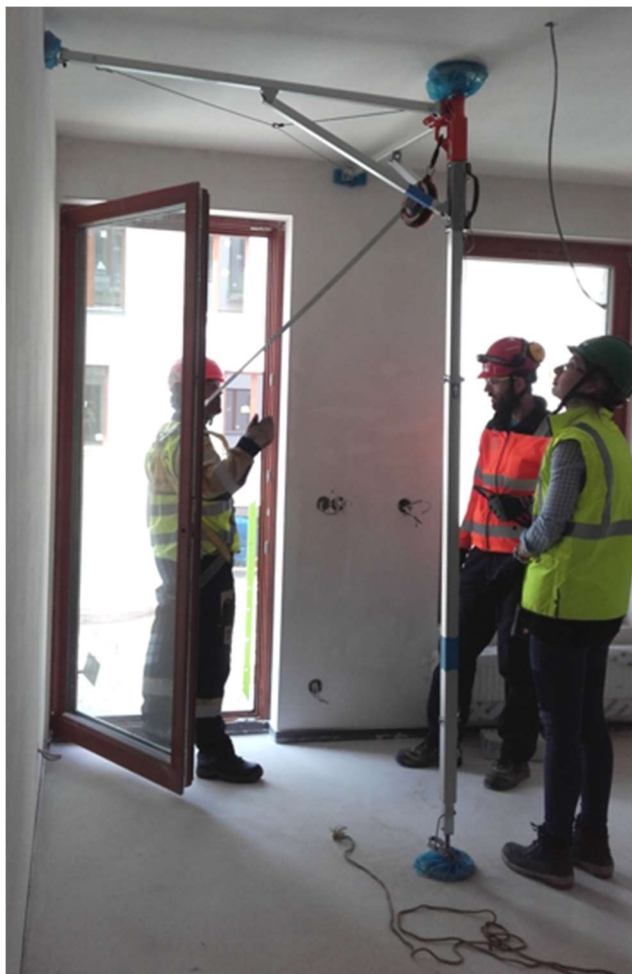
Obrázek 60 - Rozpěrný kotvicí bod
