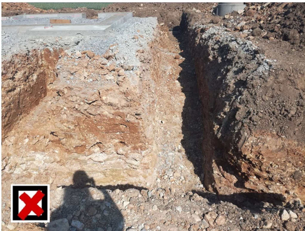
Obrázek 21 - Chybějící lávky pro bezpečný přechod (Zdroj: vlastní)
