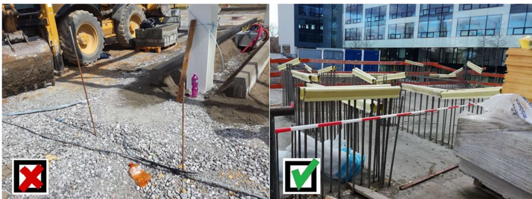
Obrázek 25 - Řešení rizika poranění o výztuž krytkami
