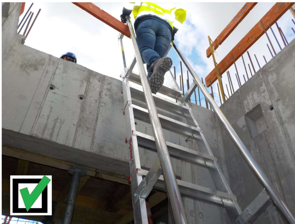
Obrázek 46 - Bezpečný výstup, přesah žebříku 1,1 m (Zdroj: vlastní)
