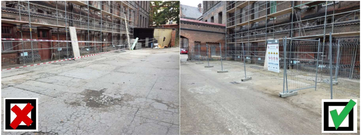
Obrázek 34 - Ohrazení nebezpečného prostoru pod pracemi ve výšce (Zdroj: vlastní)
