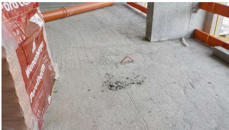
Obrázek 56 - Fixní kotvicí bod z betonářské výztuže
