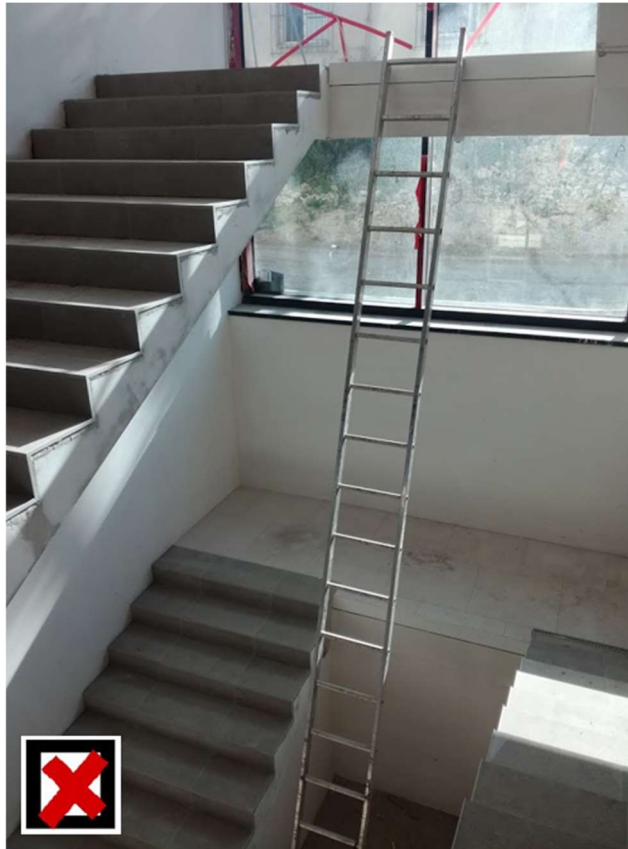
Obrázek 9 - Nepřípustný způsob použití žebříku (Zdroj: vlastní)
