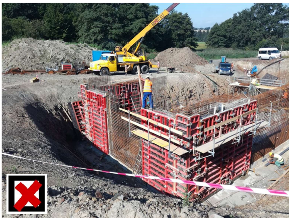
Obrázek 23 – Zakázaný způsob provádění betonáže stěn (Zdroj: vlastní)
