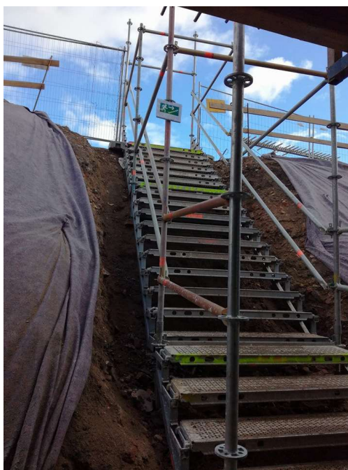
Obrázek 17 - Vstup do výkopu pomocí schodiště
