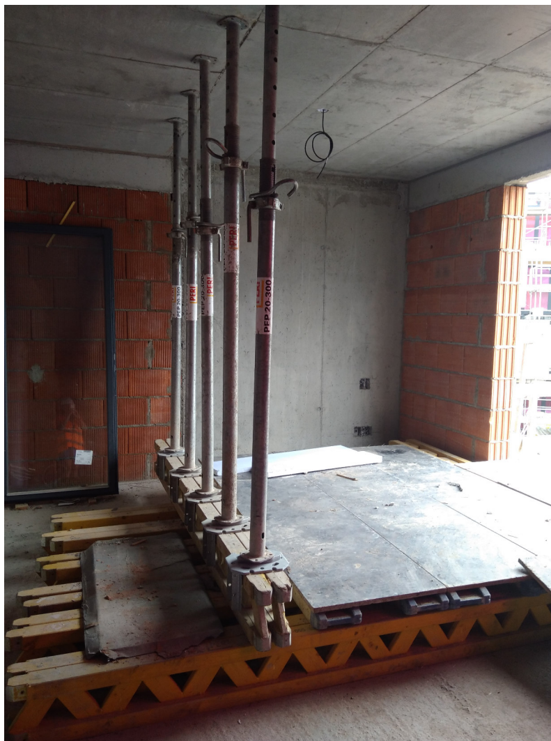
Obrázek 4.2: Konzola z nosníků a bedněň pro dopravu materiálů (archiv autora)
