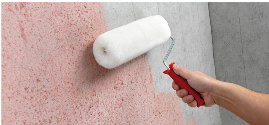
Obrázek E.3: Aplikace podkladního nátěru (převzato z [22])
