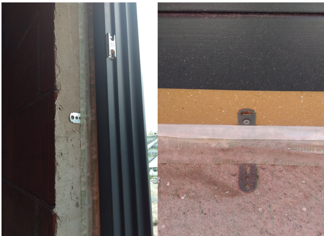
Obrázek F.3: Vyrovnání ostění a připojovací spára (archiv autora)
