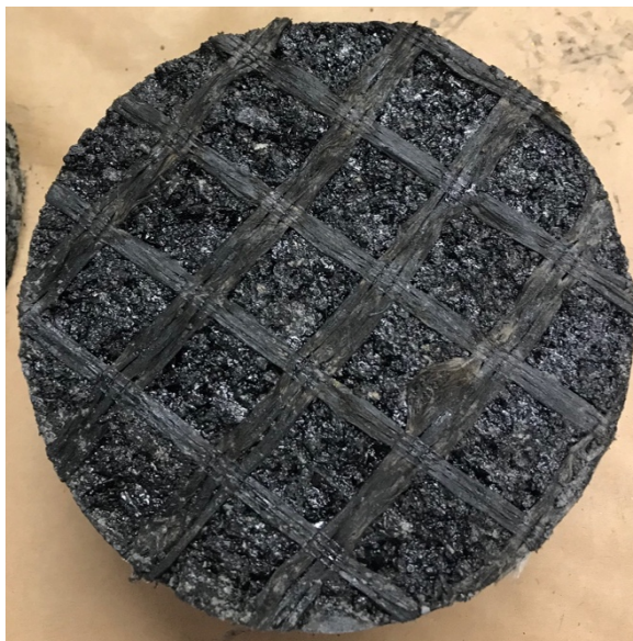
Obrázek 35 - Održena podkladní vrstva vývrtu v místě geomříže
