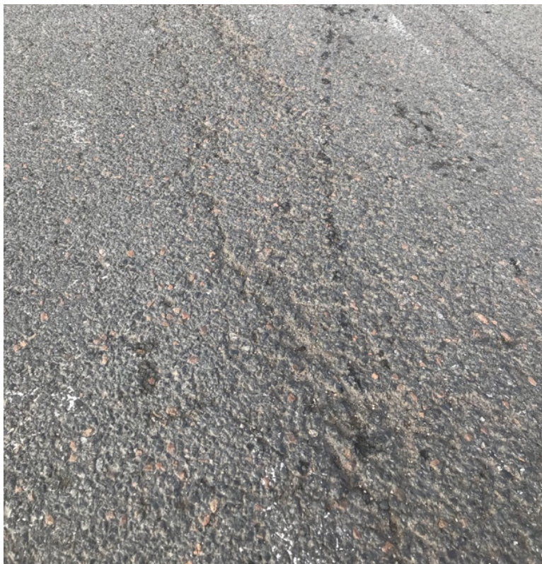
Obrázek 24 - Ztráta tmele z nátěru
