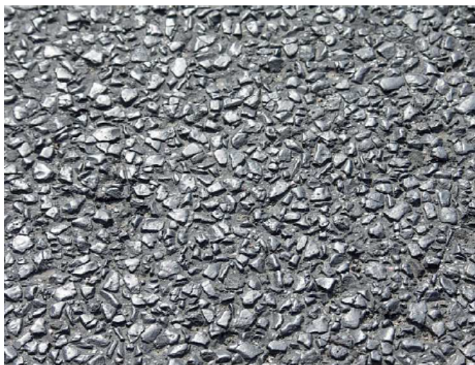
Obrázek 3 - Povrch asfaltového krytu – ohlazení nekvalitního kameniva
