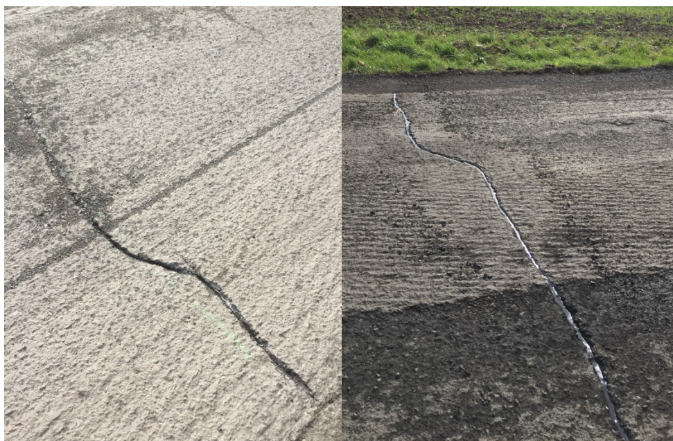
Obrázek 16 - Výsrava trhlín – proříznutí a zalití asfaltovou záливkou
