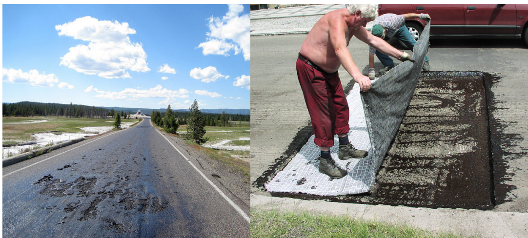
Obrázek 17 - Aplikace spojovacího postříku – hodně/málo
