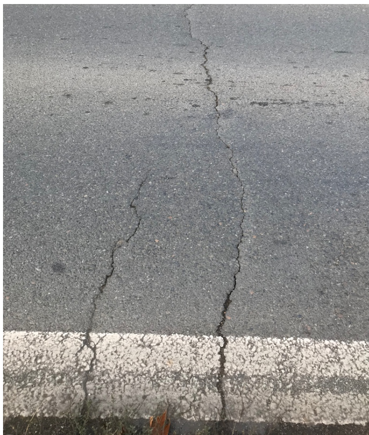
Obrázek 25 - Příčná trhлина
