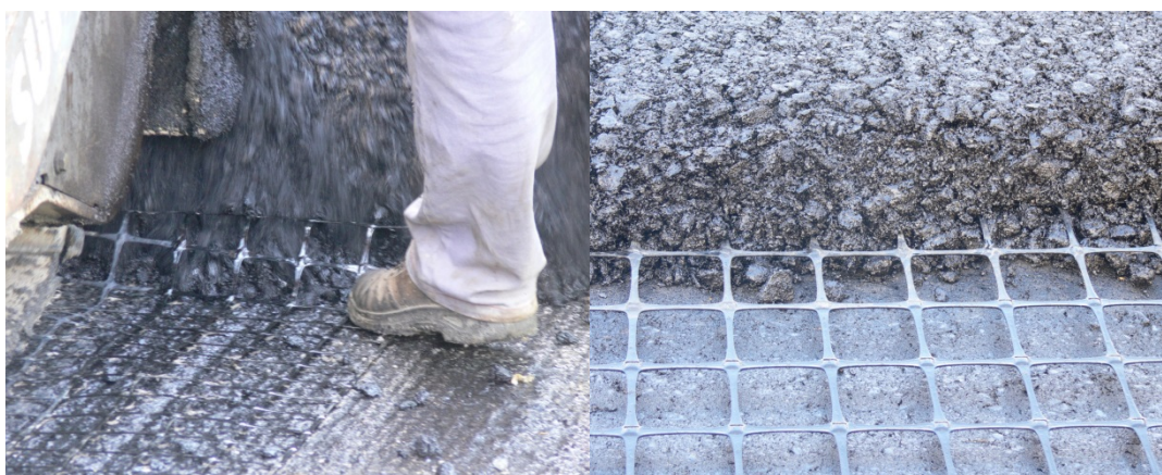
Obrázek 19 - Pokládka asphaltových vrstev – tvorba vln/nadzdvížení výztuhy
