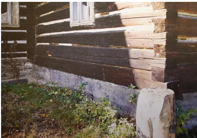
Obr. 6 Výminek – betonový základ (vlastní zdroj)
