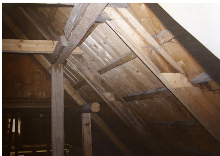
Obr. 8 Hambalkový krov - úprava (vlastní zdroj)
