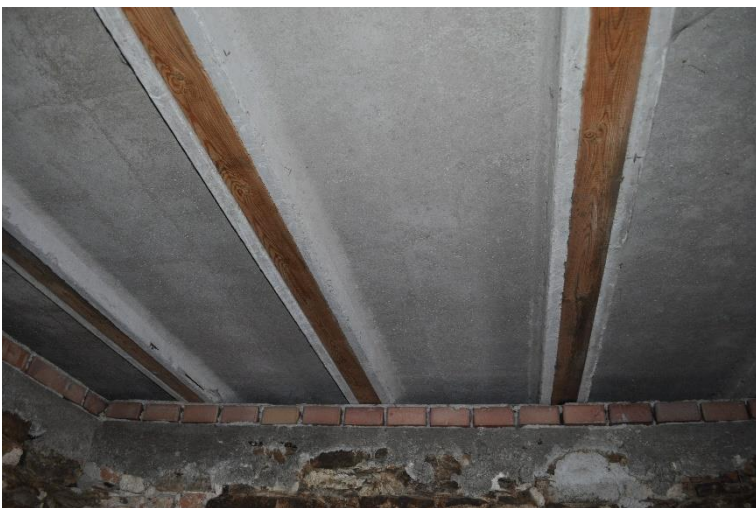
Obr. 7 Dřevo-betonový strop (vlastní zdroj)
