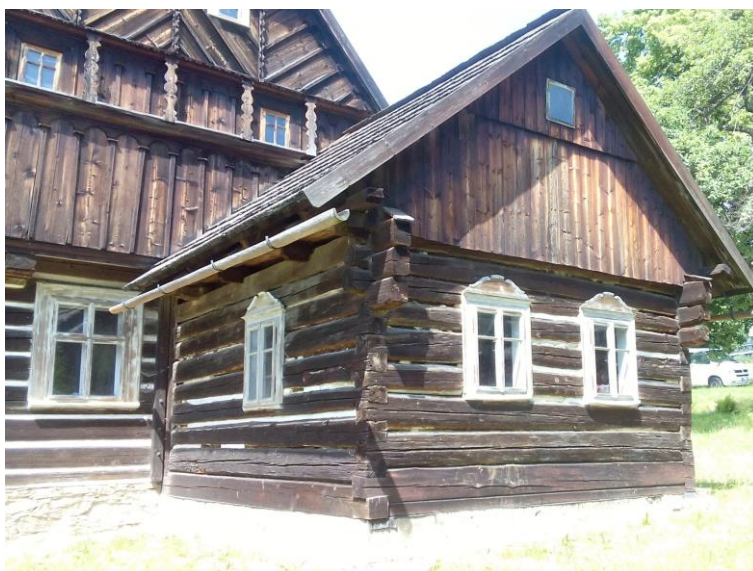
Obr. 12 Roubený přístavek (vlastní zdroj)
