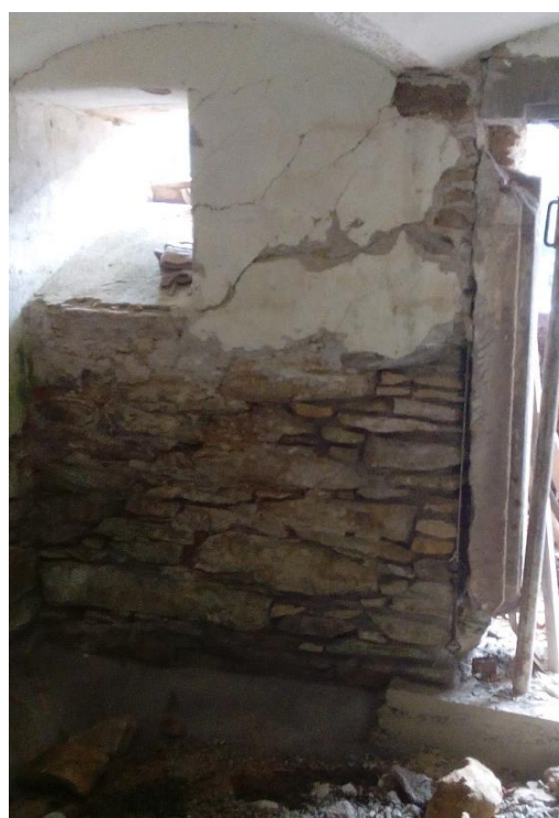
Obr. 9 Sklepní prostor - odhalené zdivo (vlastní zdroj)
