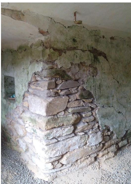
Obr. 11 Sklepní prostor - oprava rohu (vlastní zdroj)
