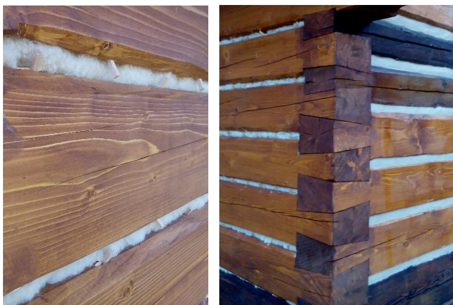
Obr. 45 Realizace výplně a tmelení spár, ilustrační foto (vlastní zdroj)
