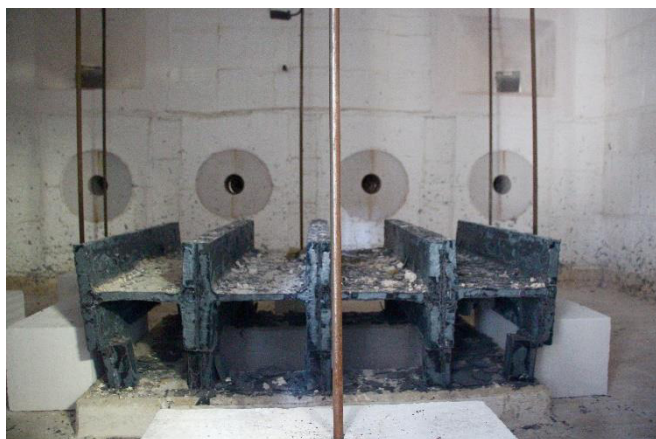
Obr. 30 Ventilační otvor s ochrannou konstrukcí
