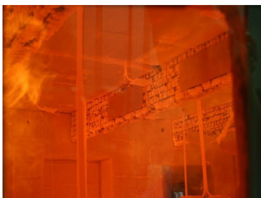
Obr. 19 Pec s dřevěnými nosníky
