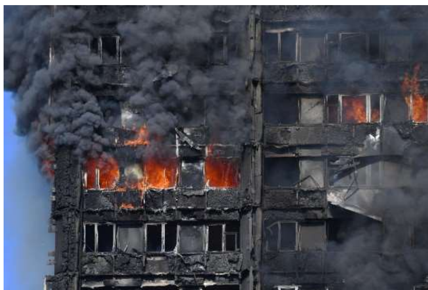
obr. 6 - Požár výškového bytového domu v Londýně 7
