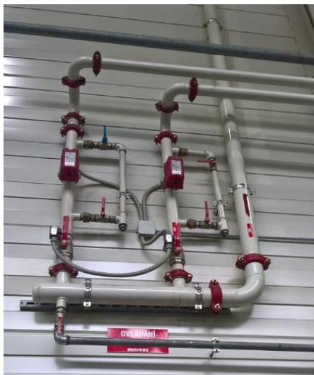
Obrázek 4 - Způsob napojení vodních clon
