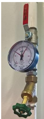
Obrázek 7 - testovací ventil
