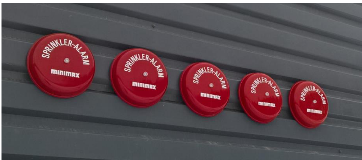
Obrázek 7 - Poplachové zvony firmy Minimax
