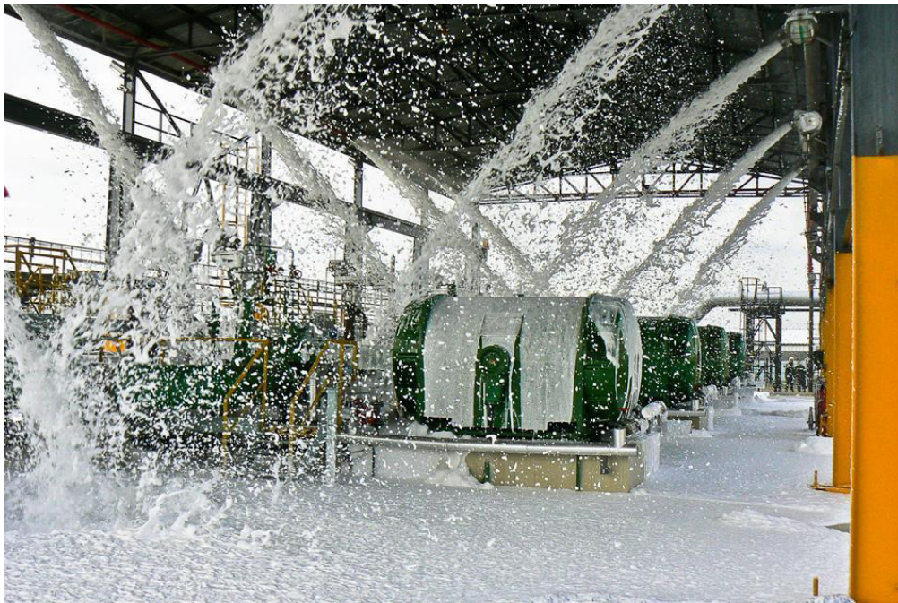
Obrázek 5 - Princip hašení pěnou [6]
