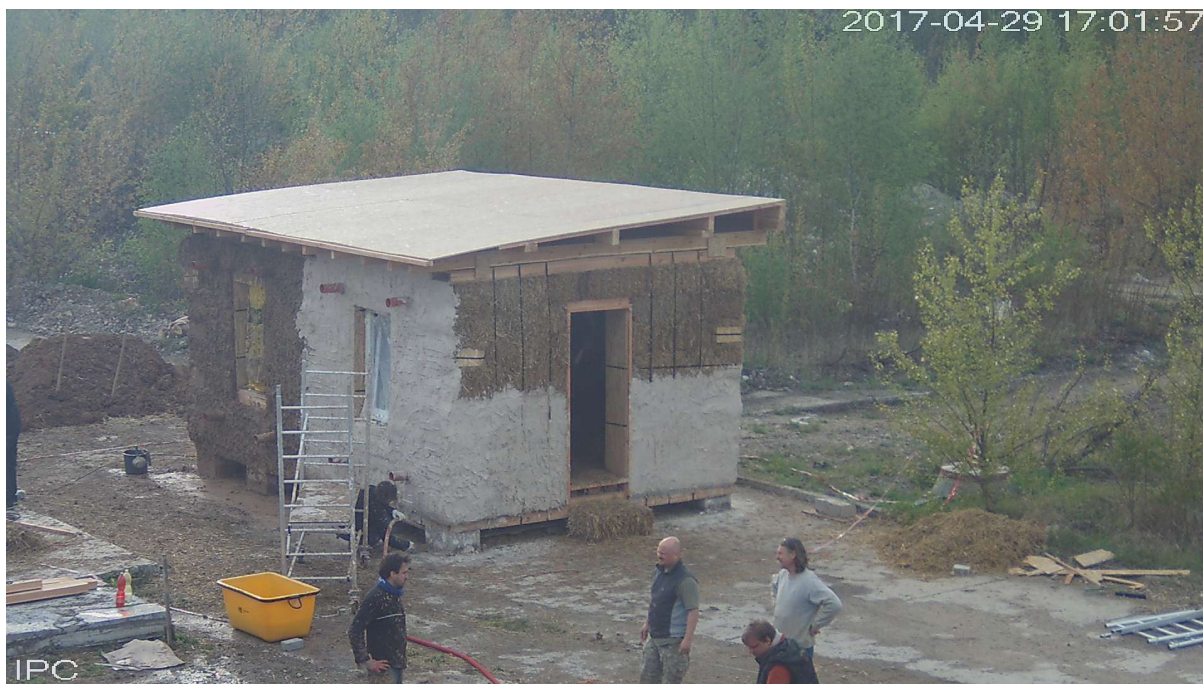
obr. 49 Realizace první vrstvy omítek
