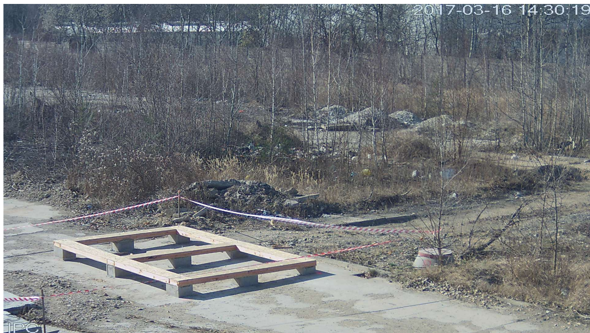
obr. 45 Osazení konstrukce spodního věnce
