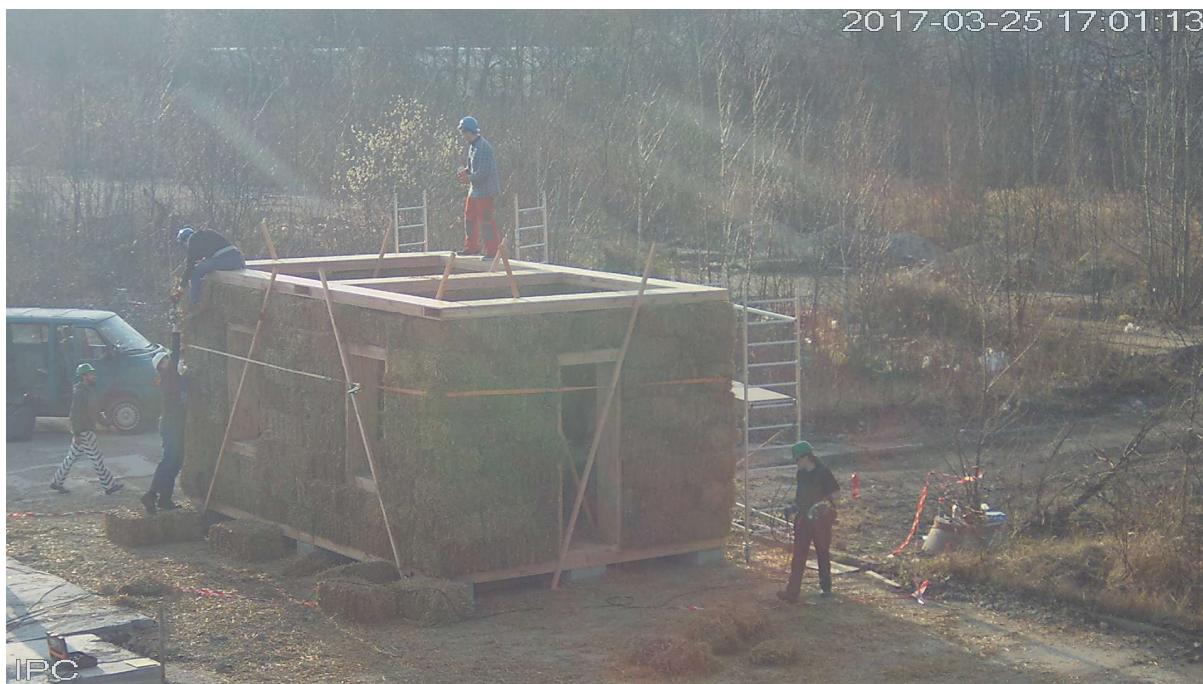
obr. 47 Vztyčení nosných stěn včetně osazení vrchního věnce
