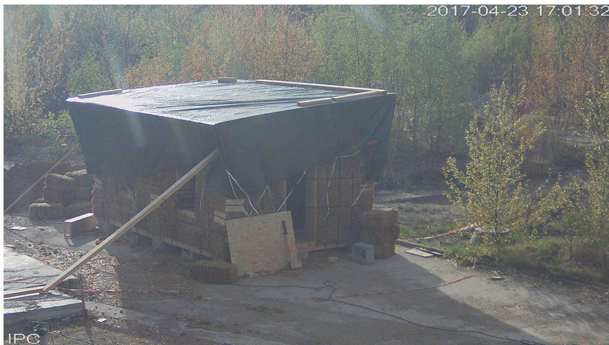
obr. 48 Realizace a zakrytí střešní konstrukce
