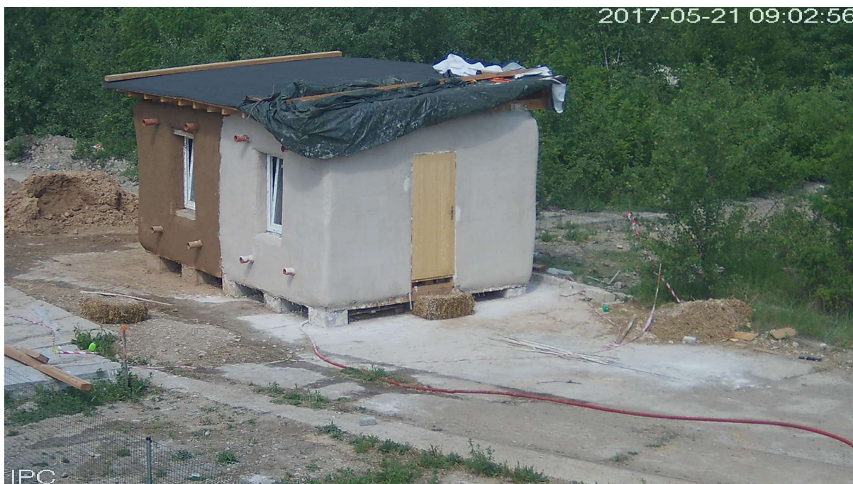
obr. 50 Realizace dalších vrstev omítek
