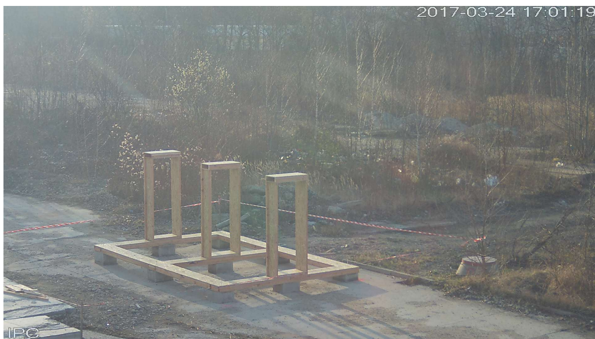
obr. 46 Osazení dveřních zárubní na konstrukci spodního věnce
