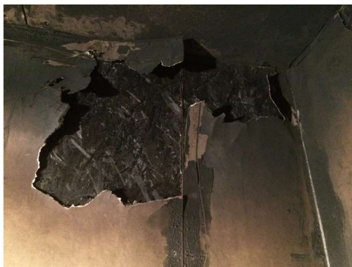
Detail odpadnuté svrchní vrstvy z Pirotitu.
