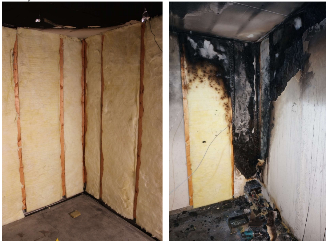
Detail rohu místnosti. Při montáži a po zkoušce.
