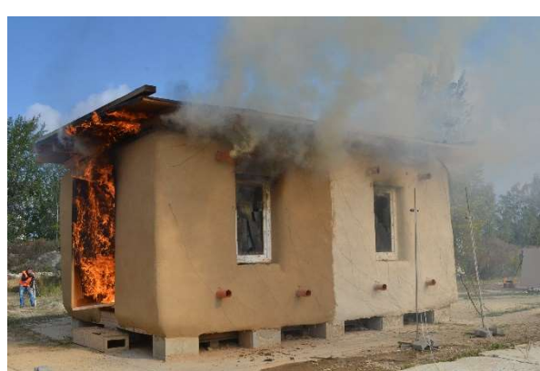
Obr. 34 Vysklené okenní otvory
