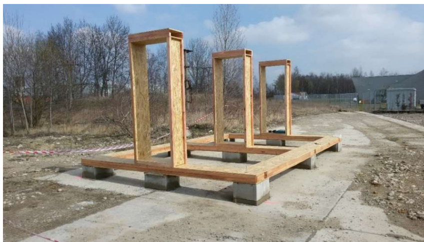
Obr. 9 Základové patky se spodním dřevěným věncem a osazenými dveřními kaslíky
