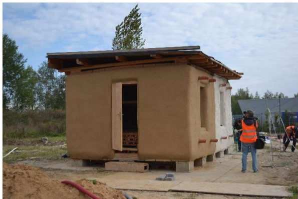
Obr. 29 Slaměný objekt před požární zkouškou (jiho-západní pohled)
