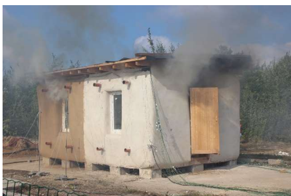
Obr. 33 Průnik kouře netěsnostmi okna v západní místnosti
