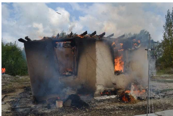
Obr. 39 Pohled na jižní obvodovou stěnu před celkovým kolapsem
