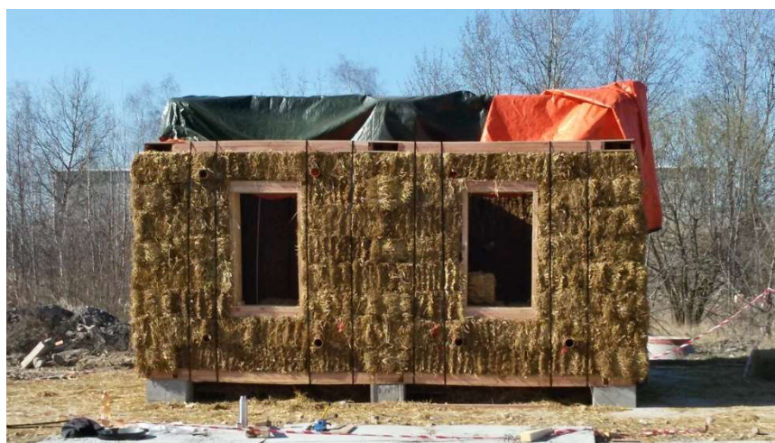
Obr. 12 Slaměná stěna včetně osazení horního věnce a stažení ocelovými páskami
