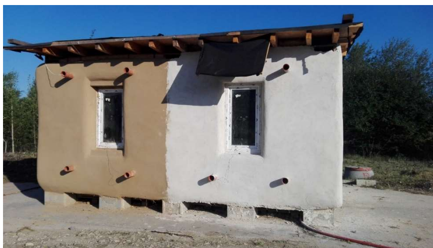
Obr. 13 Slaměný objekt s finální vrstvou omítek
