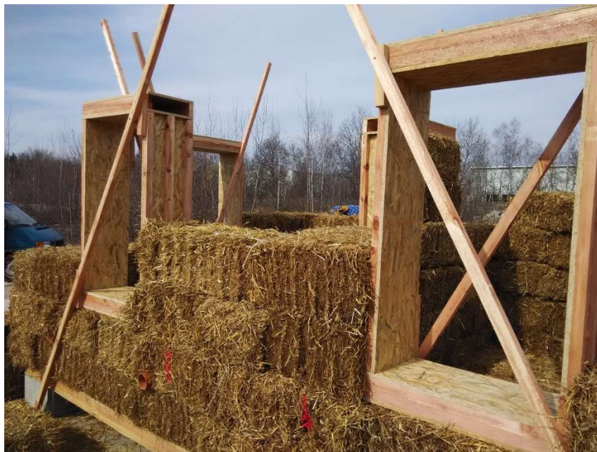
Obr. 11 Osazení okenních kaslíků do jižní obvodové stěny
