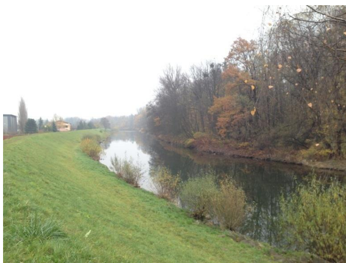
Fotografie 24 Úsek pod zaústěním řeky Ropičanky, km 39,5, levobřežní hráz (úsek mezi zaústěním řeky Ropičanky a Sadového potoka)
