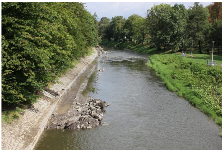
Fotografie 16 Km 38,529 pohled z lávky po vodě
