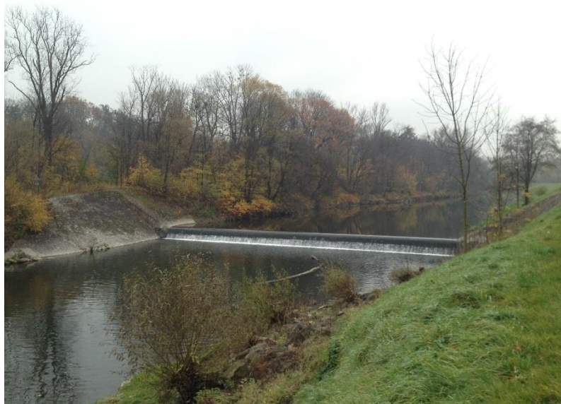
Obrázek 20 Spádový stupeň km 39,170
