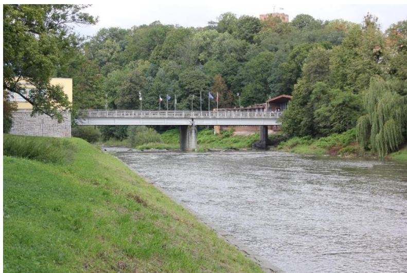
Obrázek 15 Silniční most km 37,174
