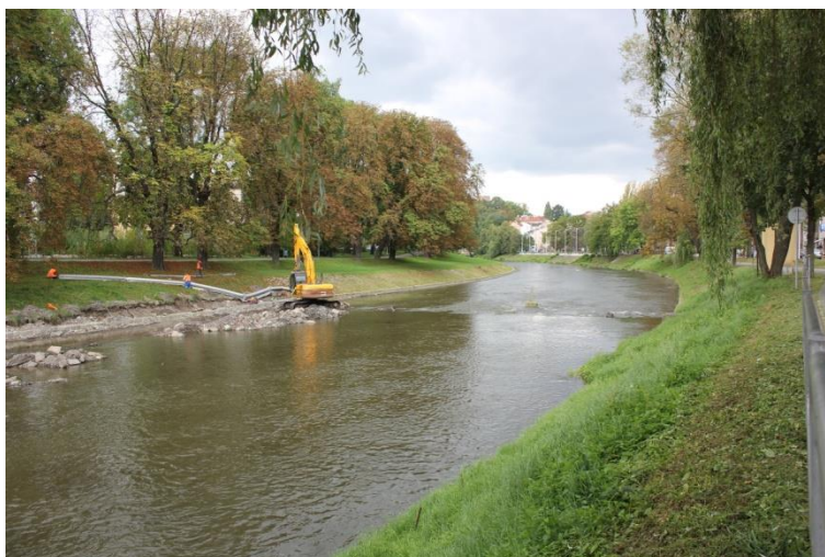
Fotografie 10 Km 37,6, právě probíhající rekonstrukce břehové patky
