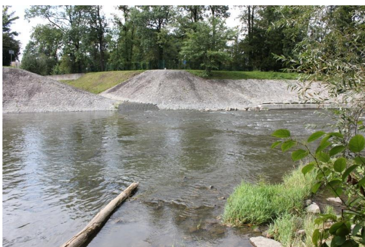
Fotografie 21 Zaústění Sadového potoka (km 38,817), pohled z pravého břehu
