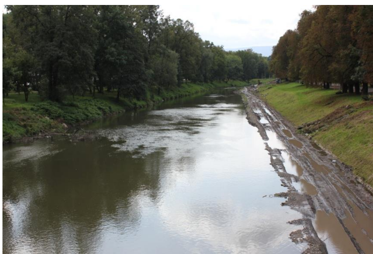
Fotografie 12 Pohled proti vodě ze silničního mostu, km 37,932
