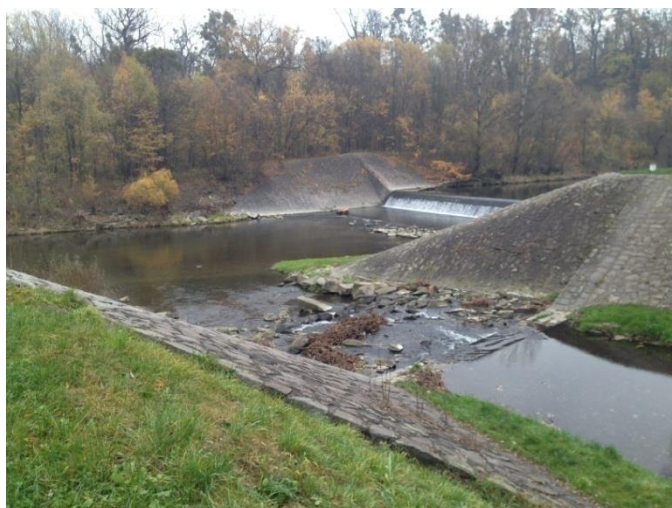
Fotografie 25 Zaústění řeky Ropičanky, pohled z levého břehu Ropičanky, km 39,6, začátek zkoumaného úseku
