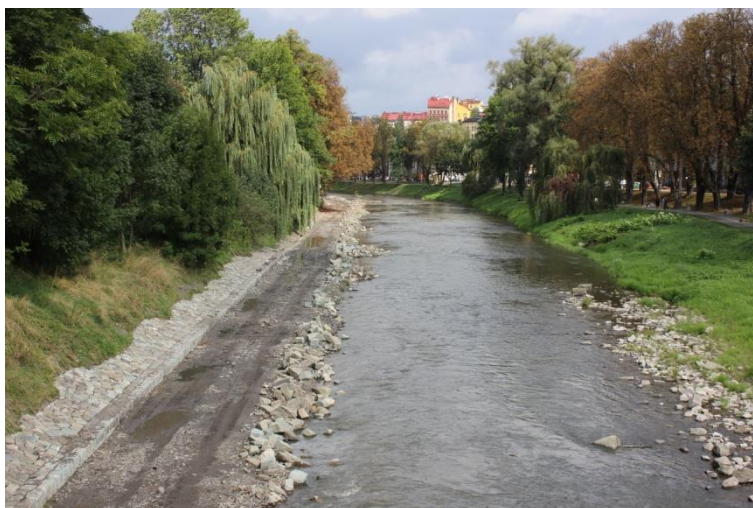
Fotografie 11 Pohled po vodě ze silničního mostu, km 37,932
