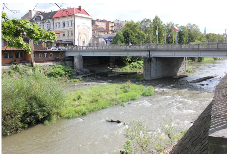
Fotografie 5 Pozůstatky pilířů původního silničního mostu (km 37,174), pohled proti vodě
