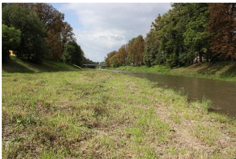
Obrázek 13 Pohled na zanesené koryto řeky Olše, km 36,9
