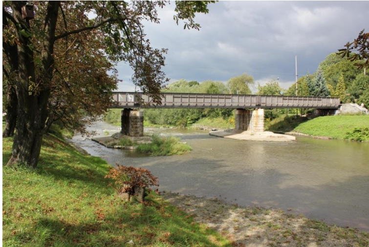
Fotografie 1 Železniční most, km 36,502, začátek řešeného úseku
