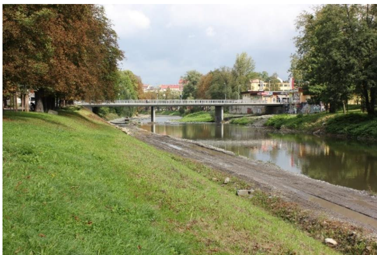
Obrázek 17 Silniční most km 37,932
