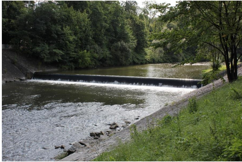
Obrázek 19 Spádový stupeň km 38,825
