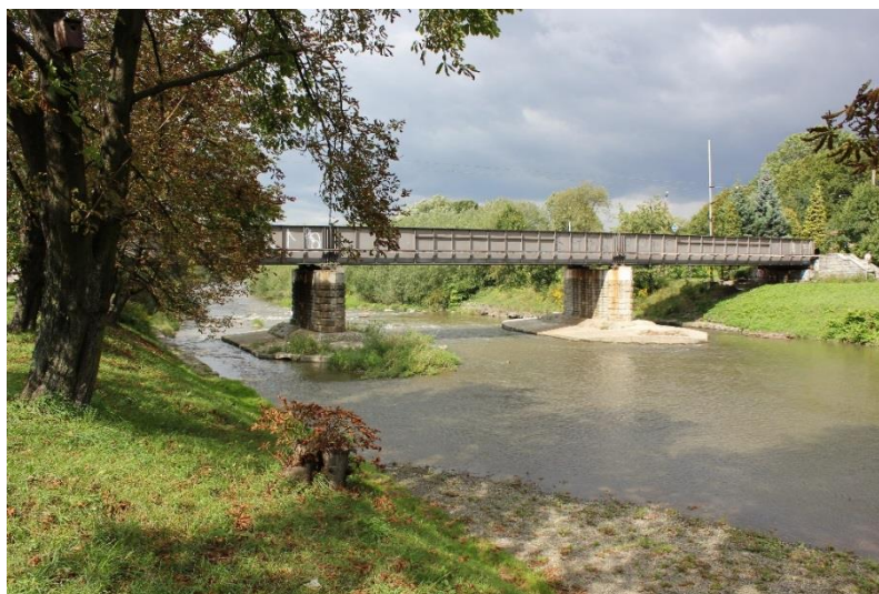
Obrázek 14 Železniční most km 36,502
