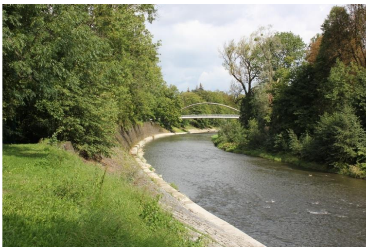
Fotografie 19 Úsek pod zaústěním sadového potoka, km 38,8
