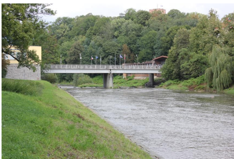
Fotografie 6 Silniční most km 37,174
