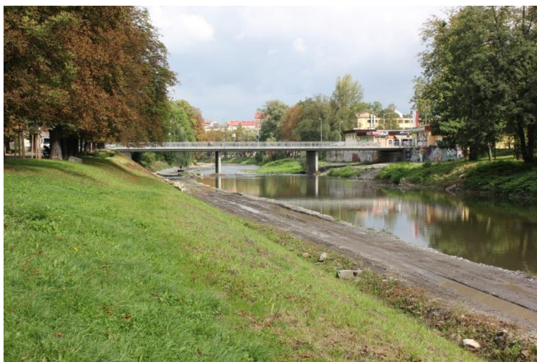
Fotografie 13 Silniční most km 37,932
