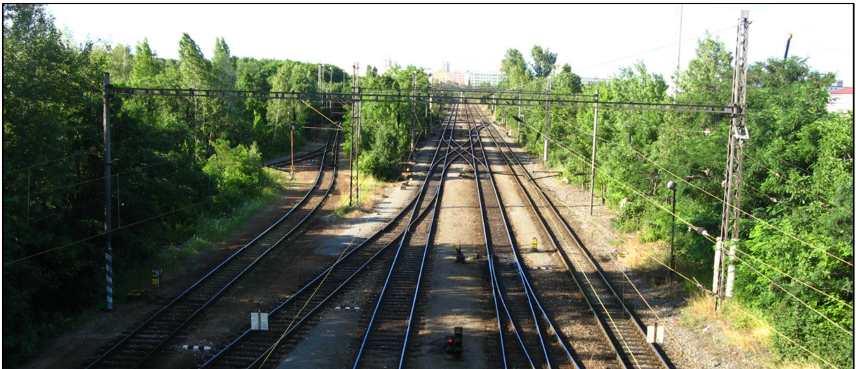
Obrázek 9: Pohled na jižní zhlaví železniční stanice Praha-Malešice. V rámci rekonstrukce železniční stanice je zde správcem infrastruktury připravována výstavba železniční zastávky Praha-Depo Hostivař.
