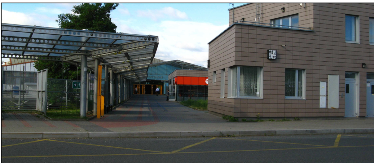
Obrázek 12: Vstup do stanice metra Depo Hostivař od nástupních zastávek. Dlouhá vzdálenost mezi nástupišti prodlužuje přestupní dobu z metra na autobus.
