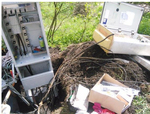
Obrázek 20 I. etapa metalická část-výměna rozvaděče [autor]
