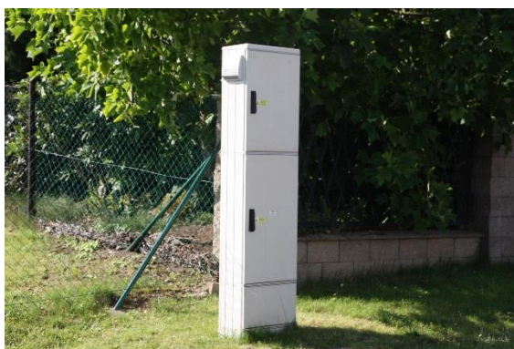
Obrázek 19 skříň MA5616 s nástavbou rDSLAM HD180 [autor]
