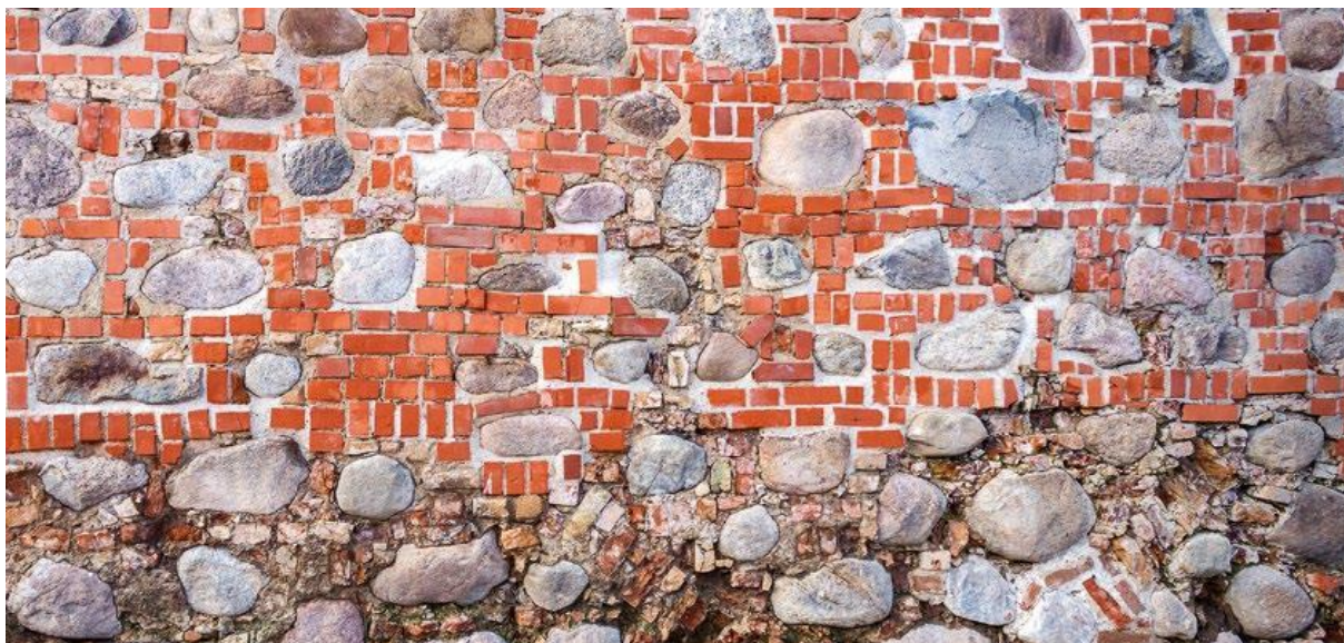
Obr. 2.5 Smíšené zdivo
