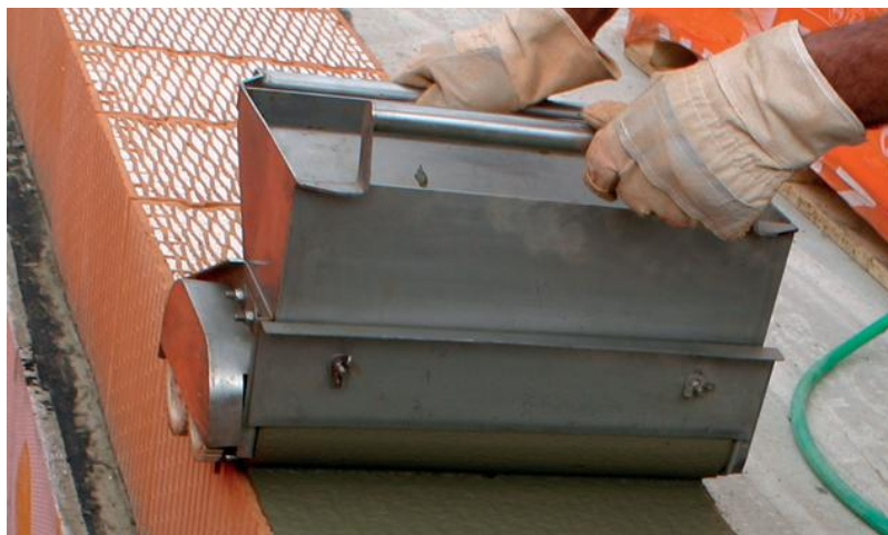
Obr. 2.14 4 Tenkovrstvé lepení keramických cihel
