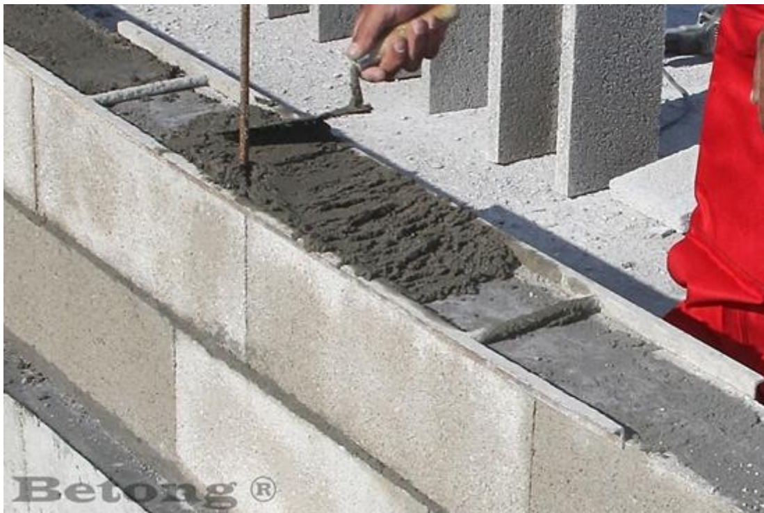
Obr. 2.208 Zdění z betonových tvárnic
