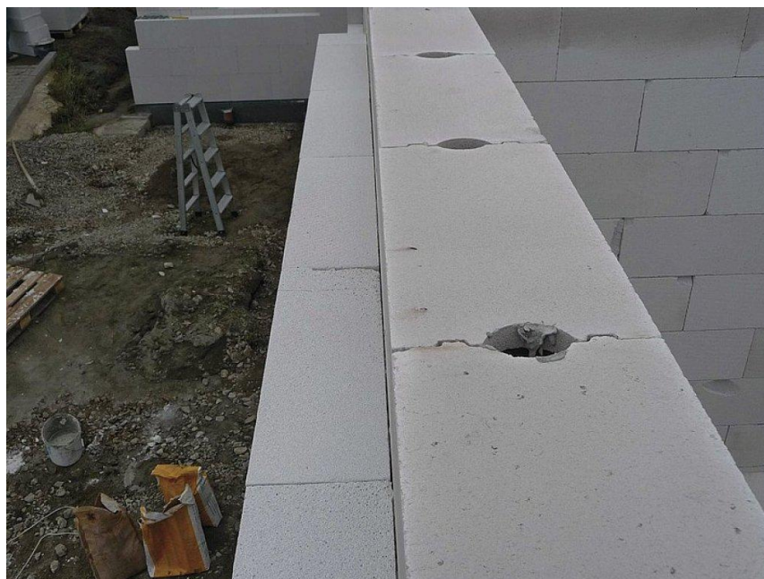
Obr. 2.17 Stěna z pórobetonových cihel
