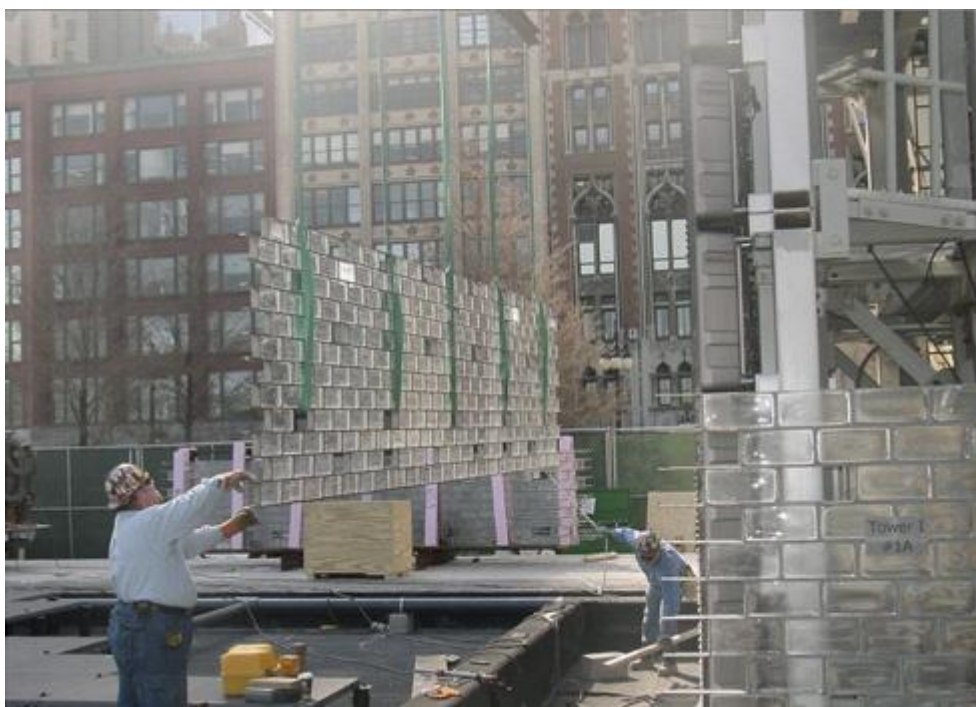
Obr. 3.910 Umístování panelu
