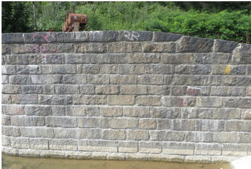
Obr. 2.4 Kvádrové zdivo
