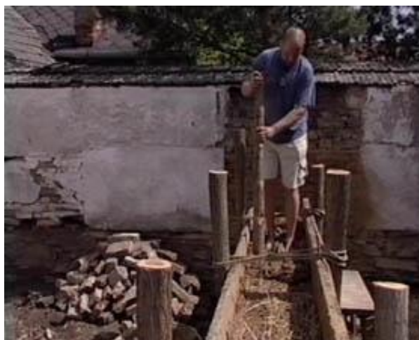
Obr. 2. 7 Nabíjené zdivo
