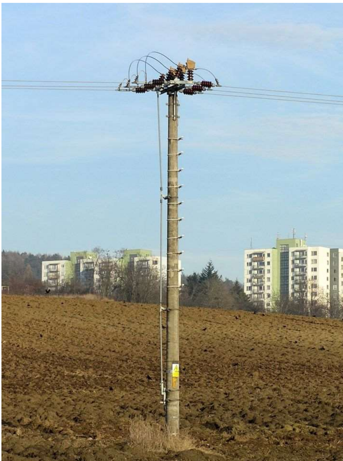
Obr. č. 19: Manuálně ovládaný úsekový odpínač [20]
