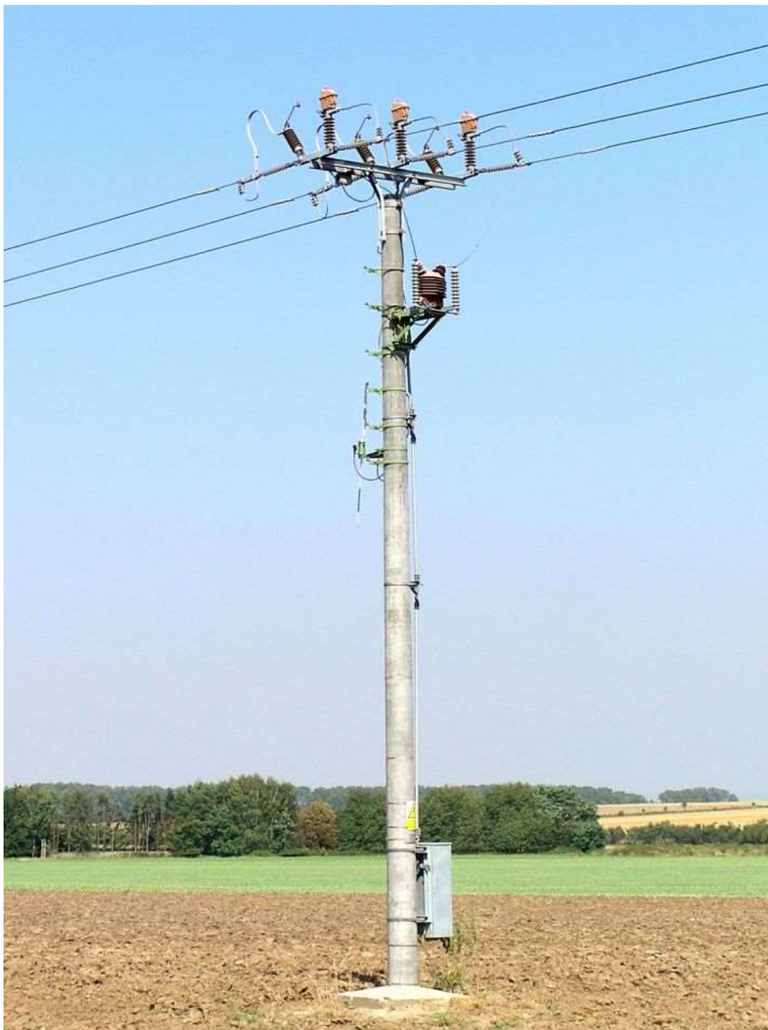
Obr. č. 20: Dálkově ovládaný úsekový odpínač [20]
