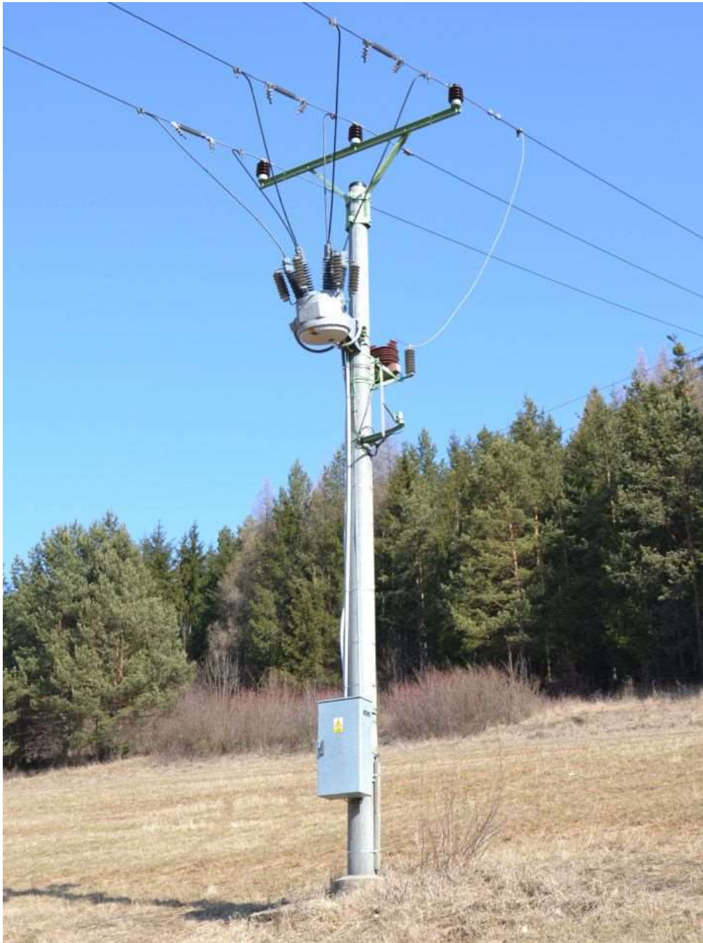
Obr. č. 21: Dálkově ovládaný vypínač RECLOSER [20]
