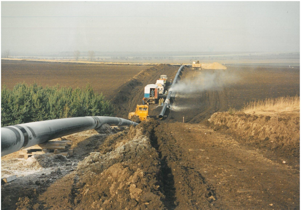
Obrázek 21 – Výstavba ropovodu IKL v ČR [7]
