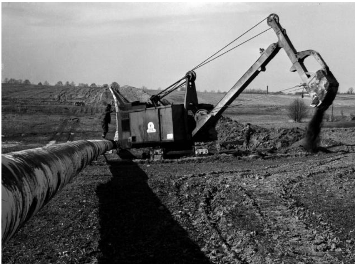
Obrázek 20 – Výstavba ropovodu Družba duben 1963 [7]
