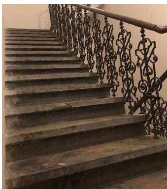
Obrázek 43: Schodiště na půdu
