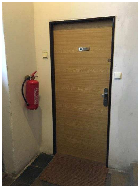
Obrázek 64: Ukázka vstupních dveří do bytu
