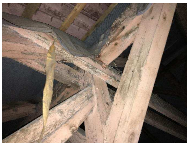
Obrázek 52: Detail napojení vzpěr a pásků krov
