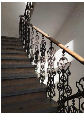
Obrázek 44: Zábradlí hlavního schodiště
