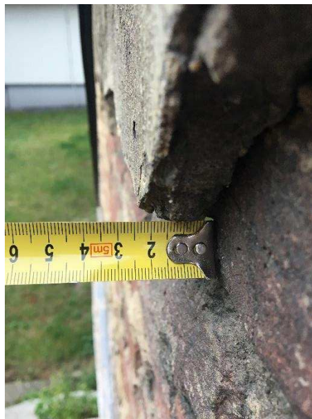
Obrázek 74: Tloušťka fasády
