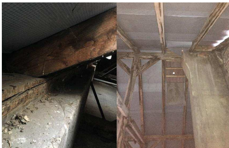
Obrázek 51: Pozednice a vaznice
