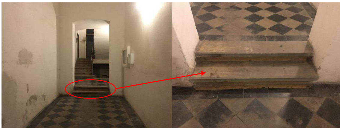
Obrázek 39: Schodiště ve vstupní hale
