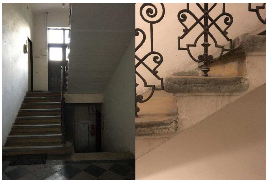
Obrázek 40: Hlavní schodiště a průřez schodů
