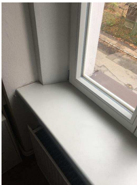
Obrázek 68: Ukázka parapetů a zalomeného ostění
