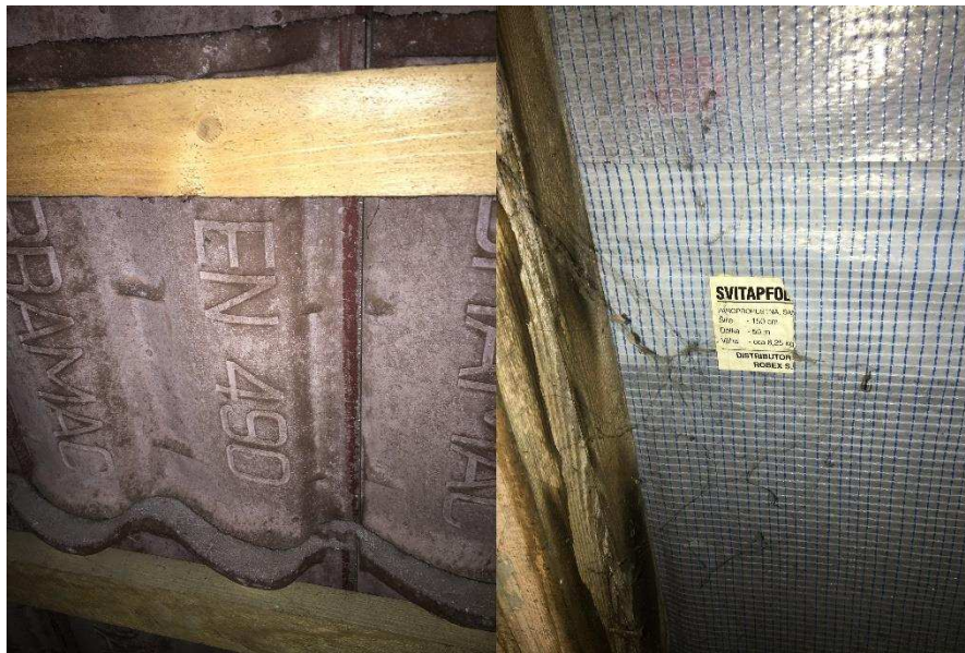
Obrázek 48: Střešní krytina BRAMAC EN 900 a pojistná hydroizolace Svitapfol
