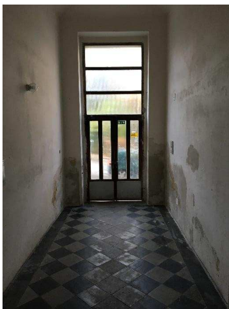
Obrázek 58: Vstupní hala domu B
