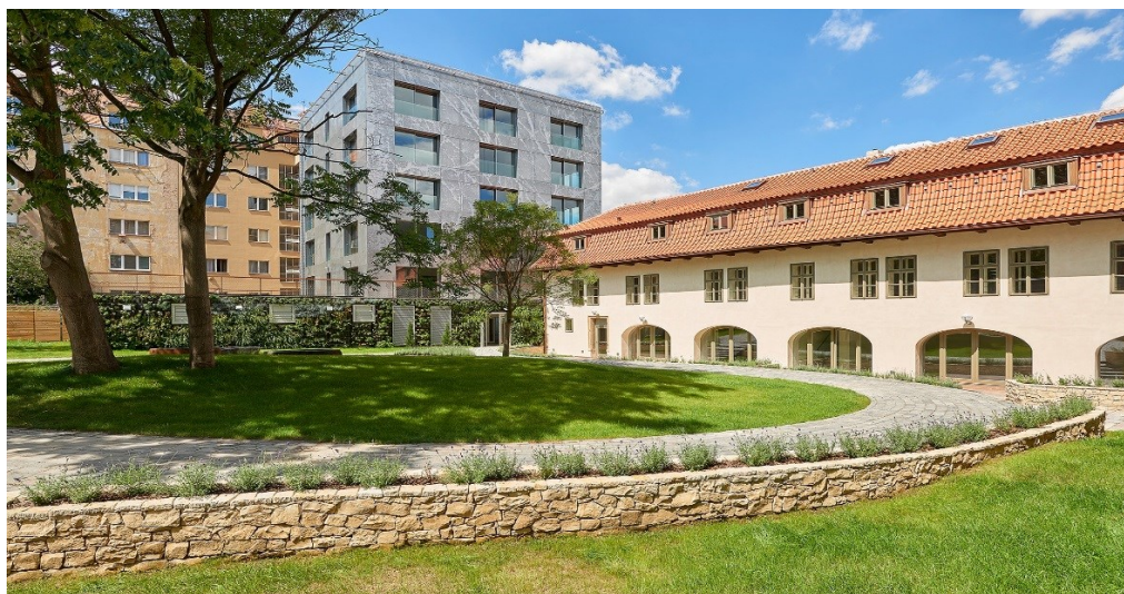
Obr. 2: Pohled z dvora
