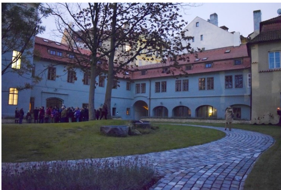
Obr. 20: Objekt D- pohled ze dvora
