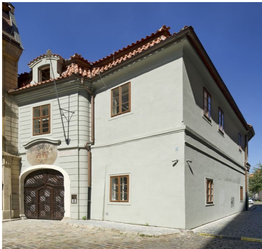
Obr. 21: Objekt D- vjezd do dvora
