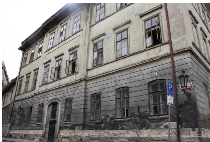
Obr. 15: Objekt C- pohled z ulice
