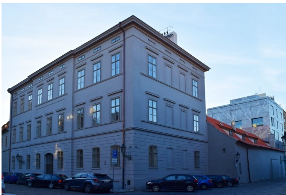
Obr. 19: Objekt C- pohled z ulice
