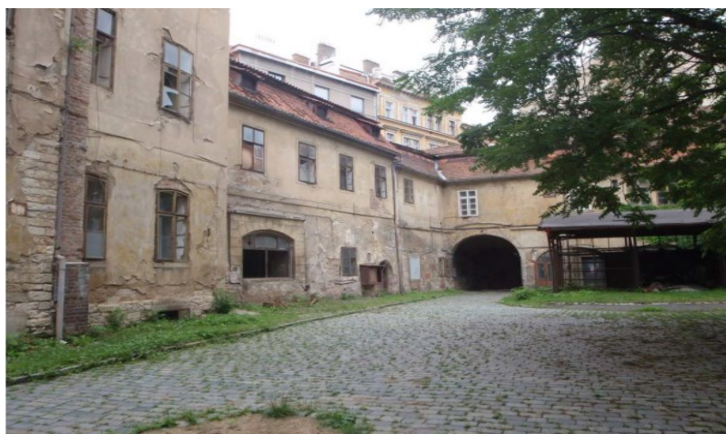
Obr. 16: Objekt D- pohled z dvora
