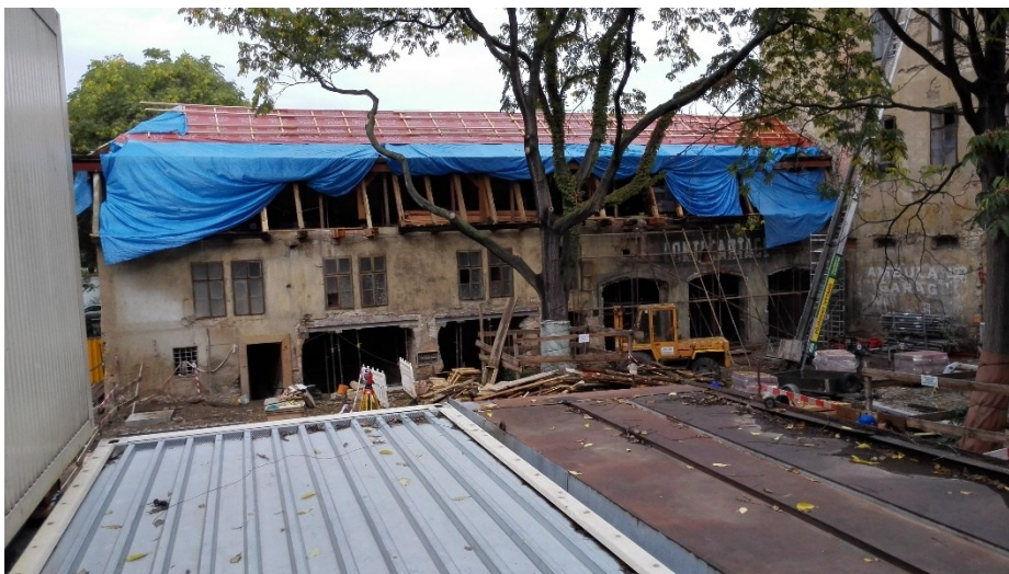
Obr. 13: Objekt B-pohled z dvora
