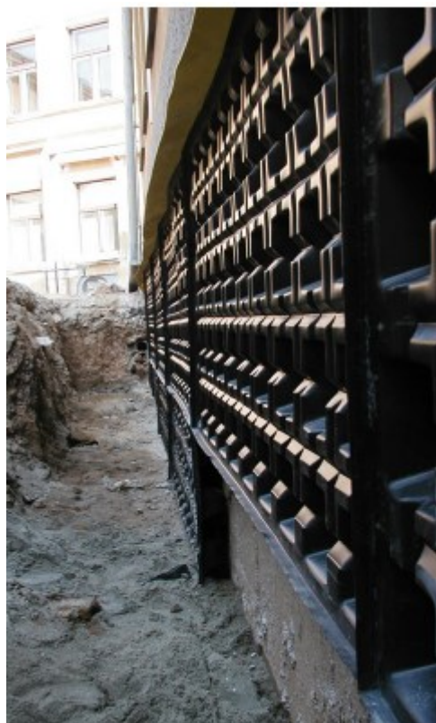
Obr. 23: Izolace obvodových stěn- desky IPT
