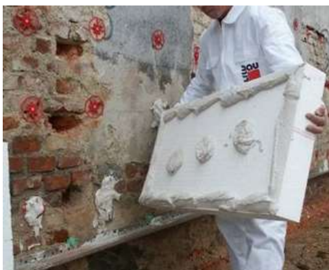
Obr. 36 – Postup lepení izolantu na kotvy
