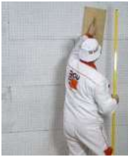
Obr. 20 – Broušení fasádních desek
