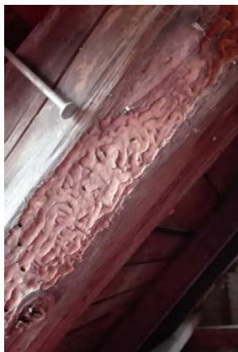
Obr. 29 napadení krokve
