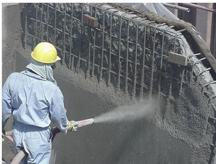
Obr. 4: Ruční nanášení stříkané betonové směsi [15]
