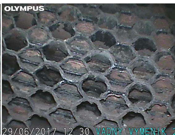
Obr. 38 Výstup primární strany výměníku před čištěním
