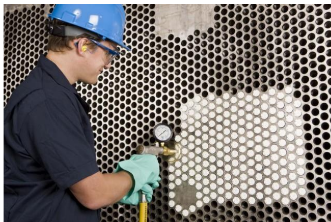
Obr. 20 Projektilové čištění [16]
