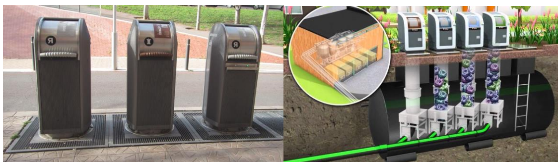
Obrázek 4: Podzemní kontejnery na Gran Via de Les Corts Catalanes a ilustrace pneumatického systému
