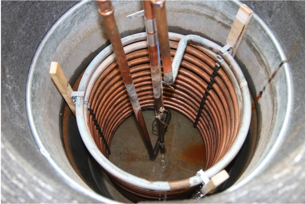
Obr. 4.7 – Výměník B uložen v jímce OV
