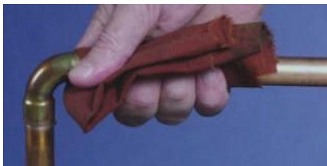
Obrázek 10. Odstranění zbytků tavidla [5]
