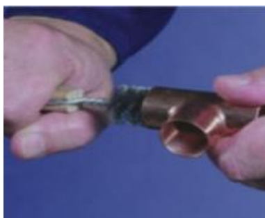
Obrázek 6. Očištění konce tvarovky [5]
