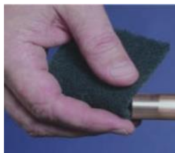
Obrázek 7. Očištění konce trubky [5]
