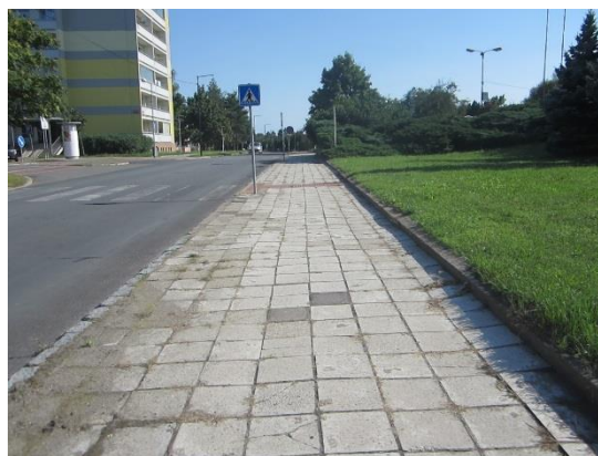
Obrázek 12 – Pohled na chodník směrem k přechodu P1.1 [Autor]
