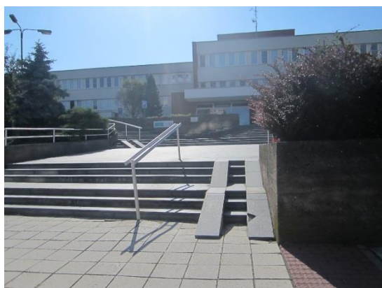
Obrázek 11 – Přístupová rampa k budově Polikliniky sídliště R1.1 [Autor]
