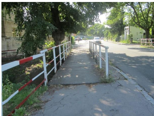
Obrázek 17 – Pohled na most na jižní straně ulice Zbožská směrem k ulici Letců R. A. F. [Autor]
