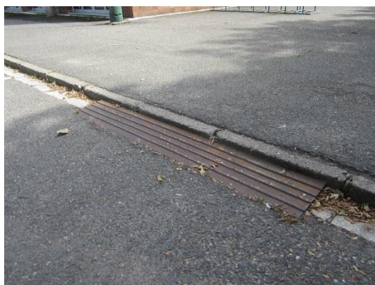
Obrázek 28 – Železná rampa na hranici parkoviště PA2.3 [Autor]
