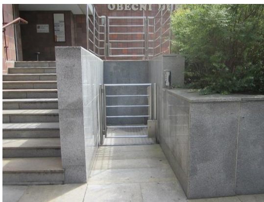
Obrázek 23 – Zdvihací plošina pro přístup k budově Obecního domu [Autor]
