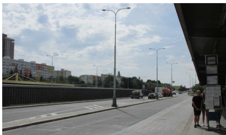
Obr. C.37 – Opatov, terminál VHD nástupiště ve směru Háje (24. 08. 2017)
