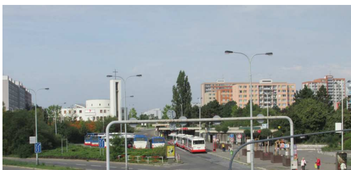
(a) Háje, Opatovská, pěší lávka (24. 08. 2017)
