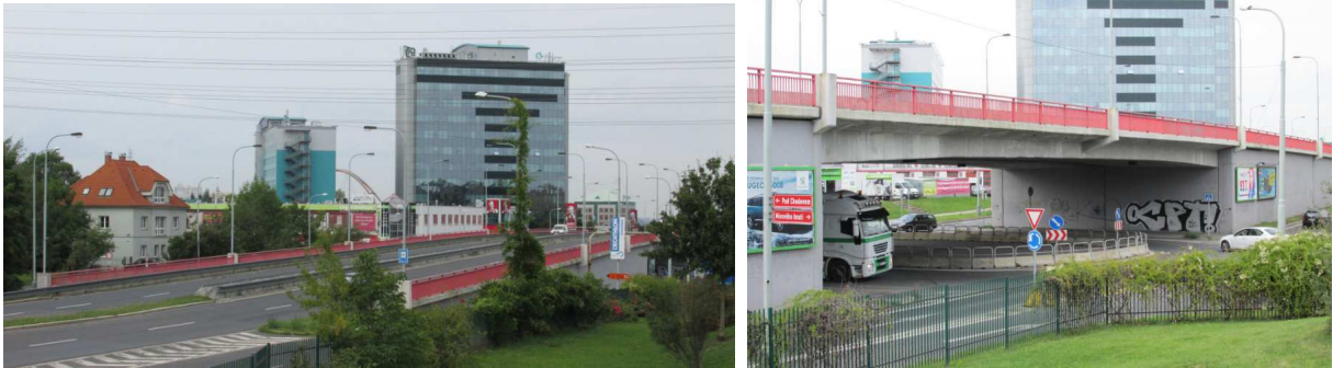
(a) Pohled na mostní objekt Türkovy ulice při pohledu směrem Chodovec (24. 08. 2017)
