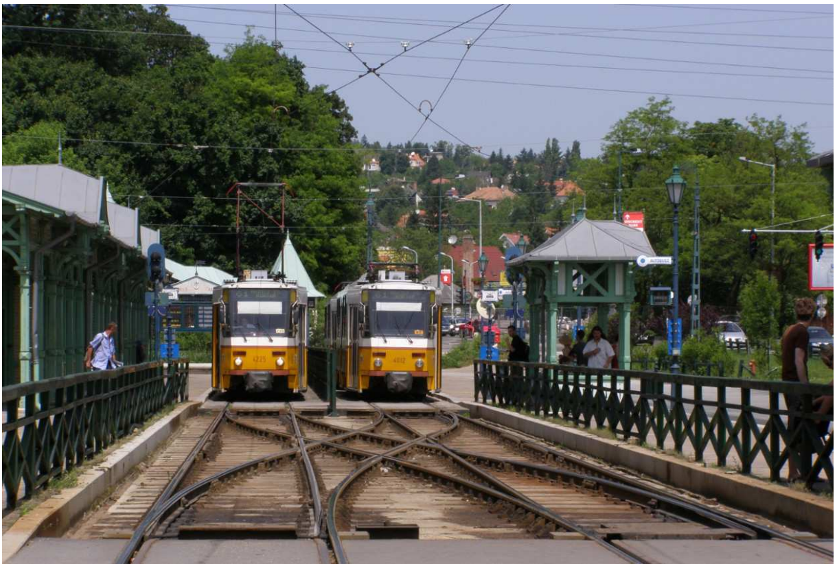
Obr. C.1 – Hűvösvölgy, dvojitá kolejová spojka, Budapešť (J. Hradil, 01. 08. 2016)
