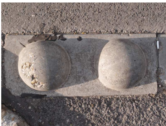
Obr. 4.4 – Betonové tvarovky typu polokoule, Budapešť (J. Hradil, 11. 07. 2015)
