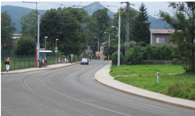
(a) Malodoubská, živičný povrch, Liberec (04. 08. 2011)
