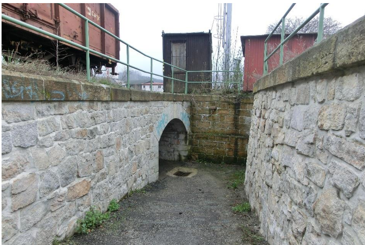
Obrázek 28 Vstup do podchodu od výpravní budovy
