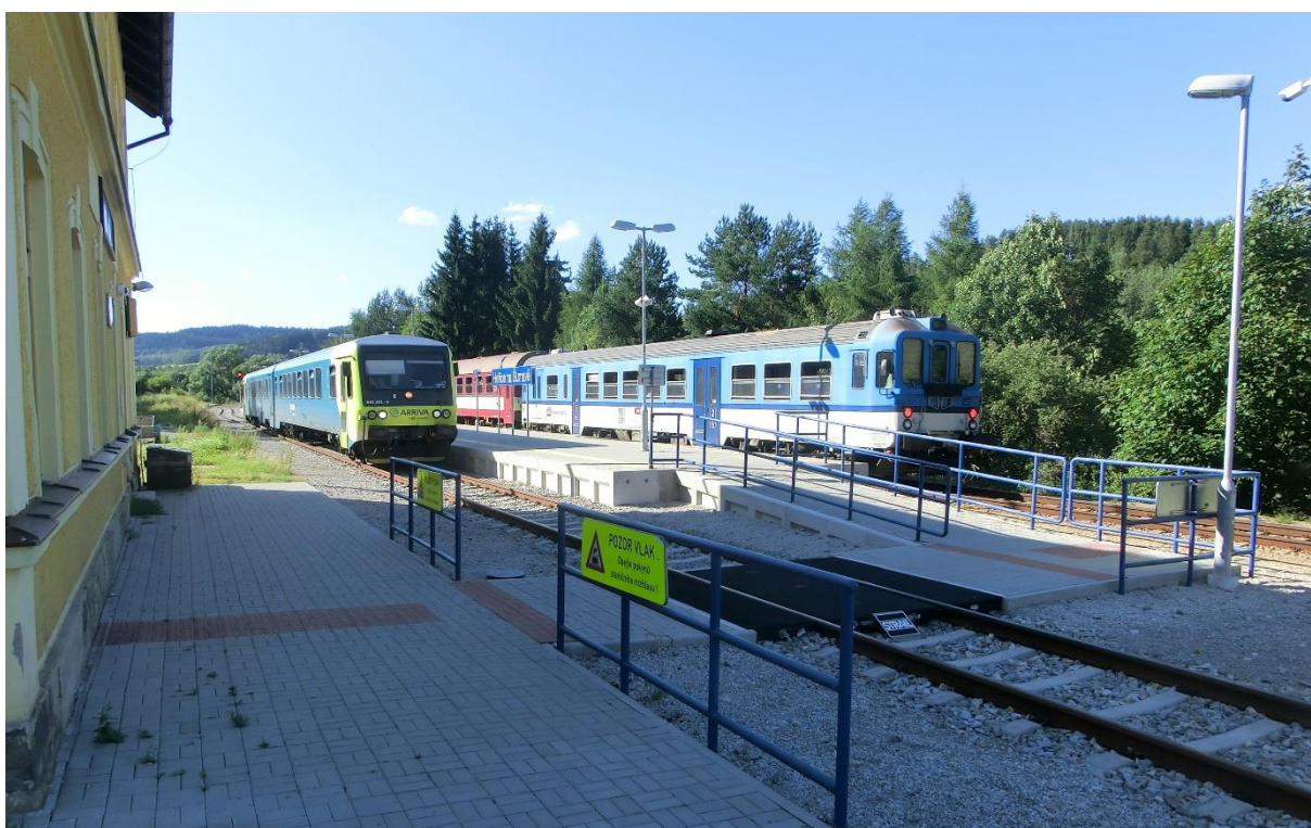
Obrázek 37 Poloostrovní nástupiště v železniční stanici Hořice na Šumavě
