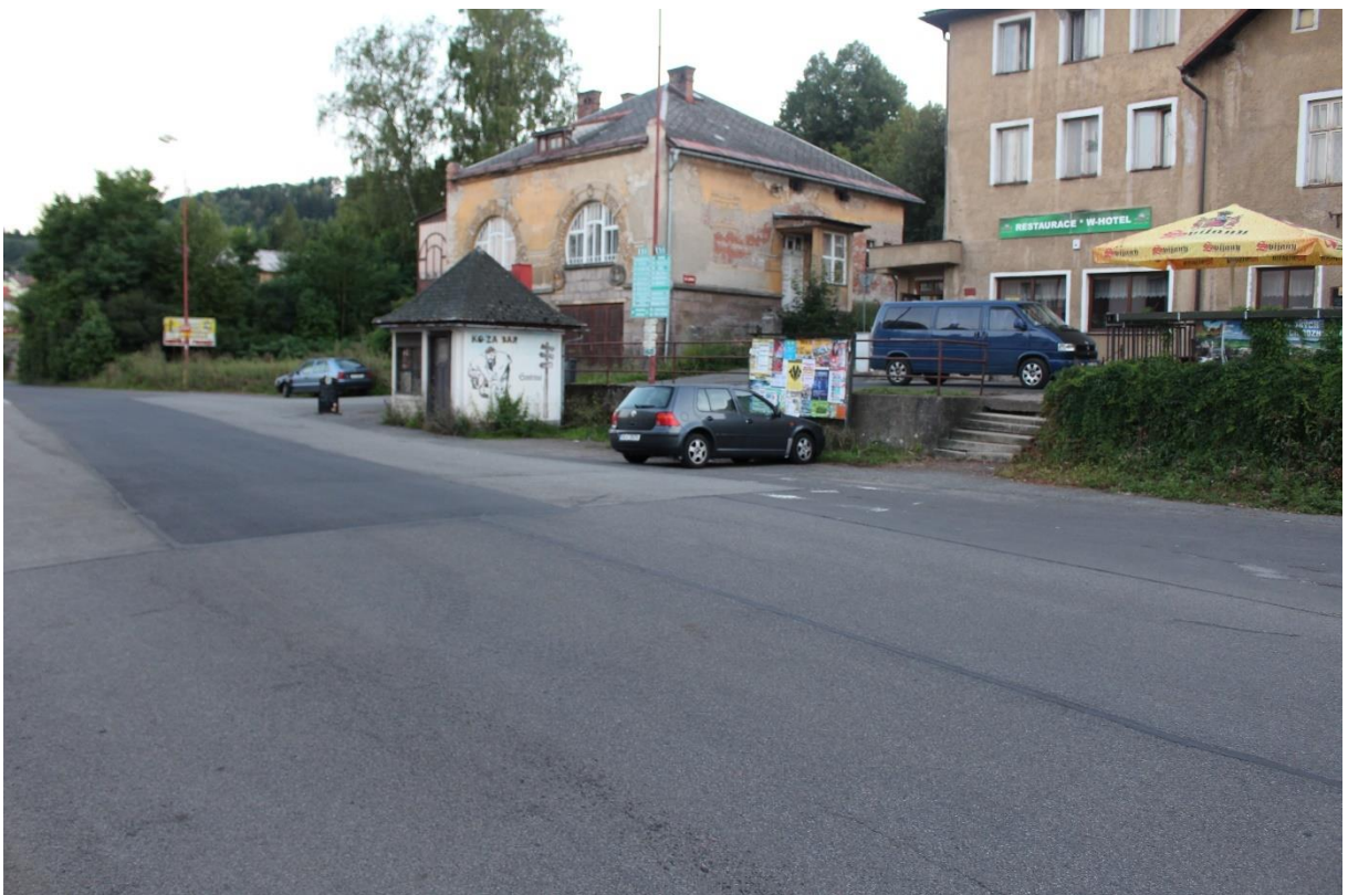
Stanoviště autobusů v Nádražní ulici (směr centrum)
