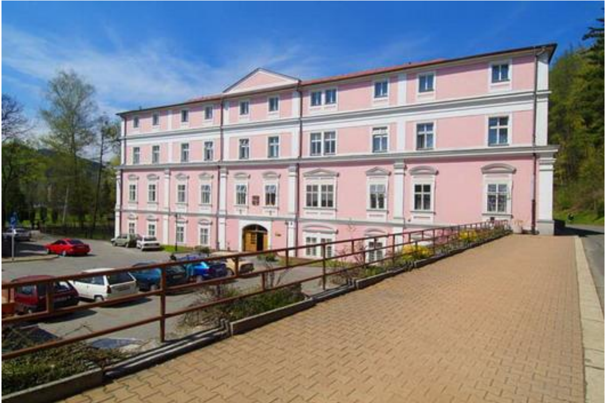
Obrázek 8 Pohled na budovu zámku Semily
