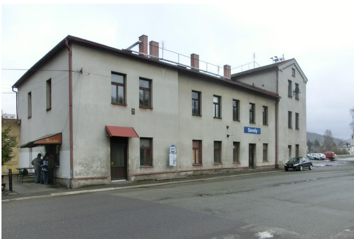
Obrázek 26 Pohled na výpravní budovu Semily z Nádražní ulice
