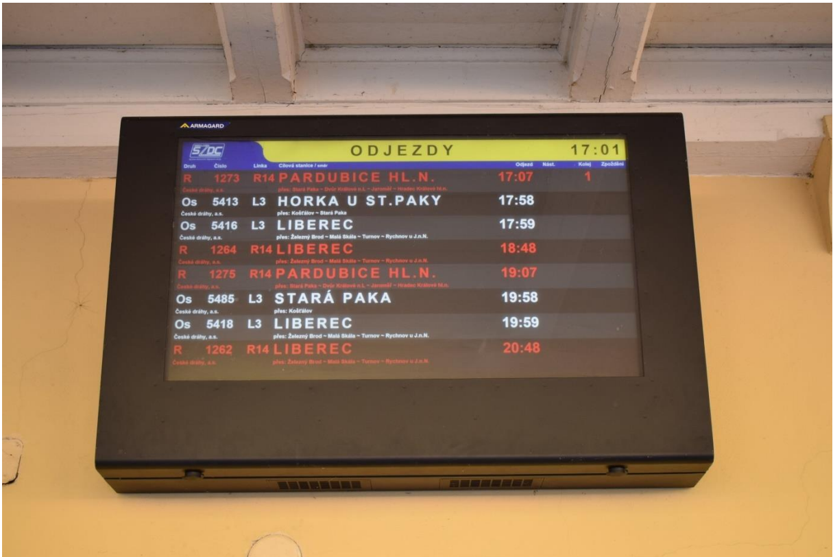
LCD displej na zdi budovy s odjezdy nejbližších vlaků
