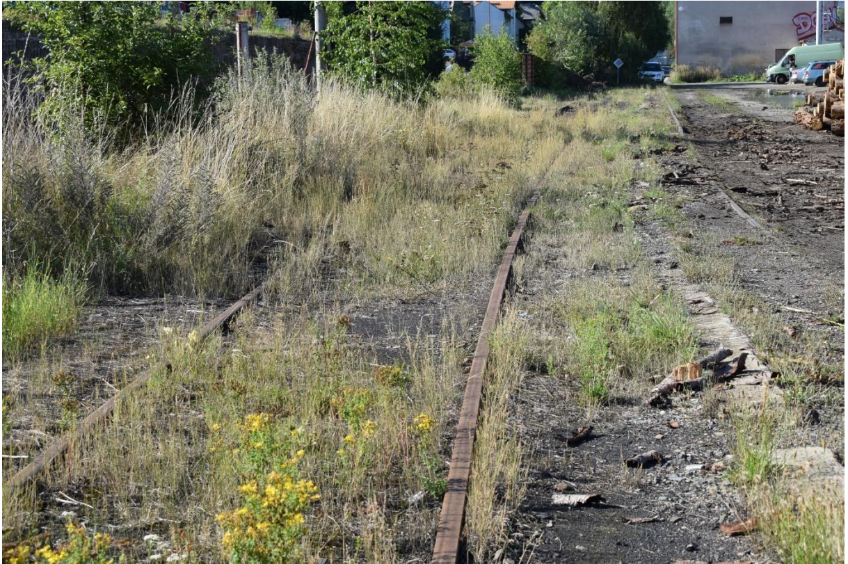
Detail neudržované manipulační koleje č. 7
