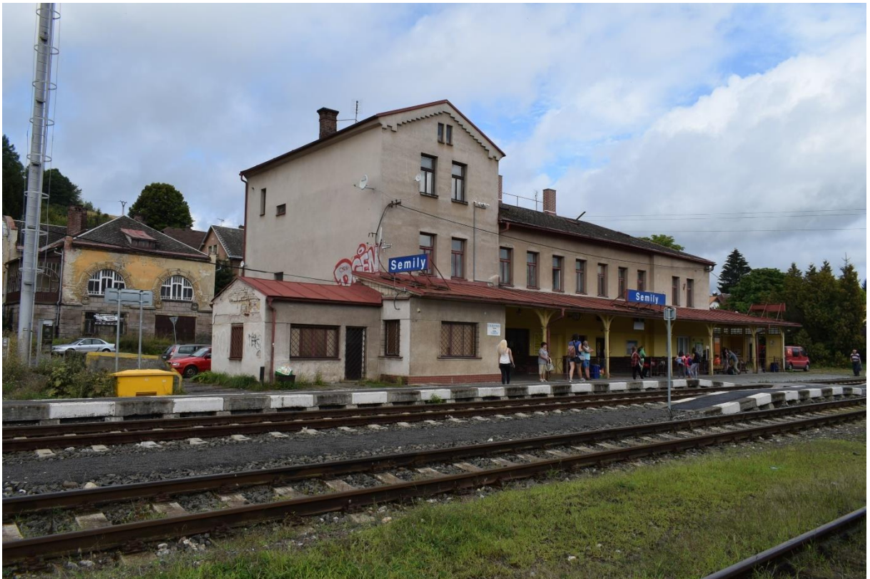
Výpravní budova ze strany od kolejíště
