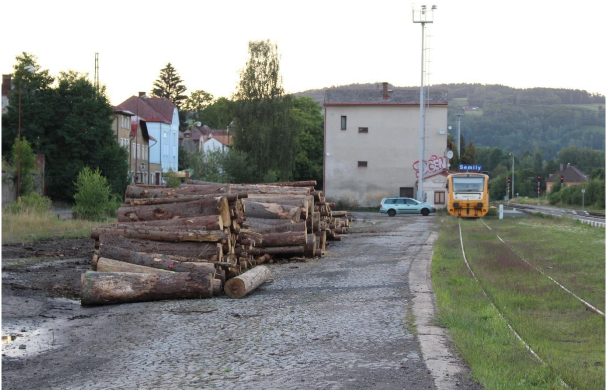
Dřevo na volné skládce připravené k nakládce a v dále odstavená jednotka řady 814 na manipulační koleji č. 5
