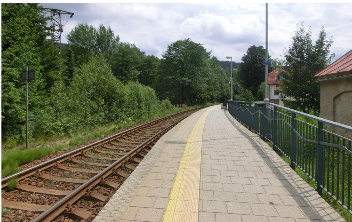
Obrázek 35 Nástupiště typu „Umsteiger“ v zastávce Železná Ruda centrum
