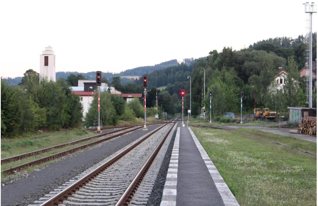
Odjezdová a seřadovací návěstidla ve směru Stará Paka
