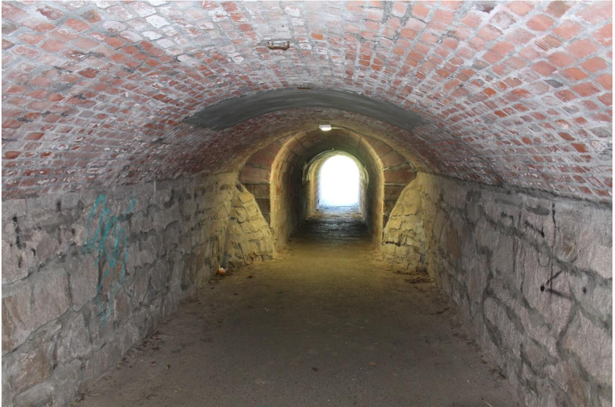
Vnitřní prostory podchodu
