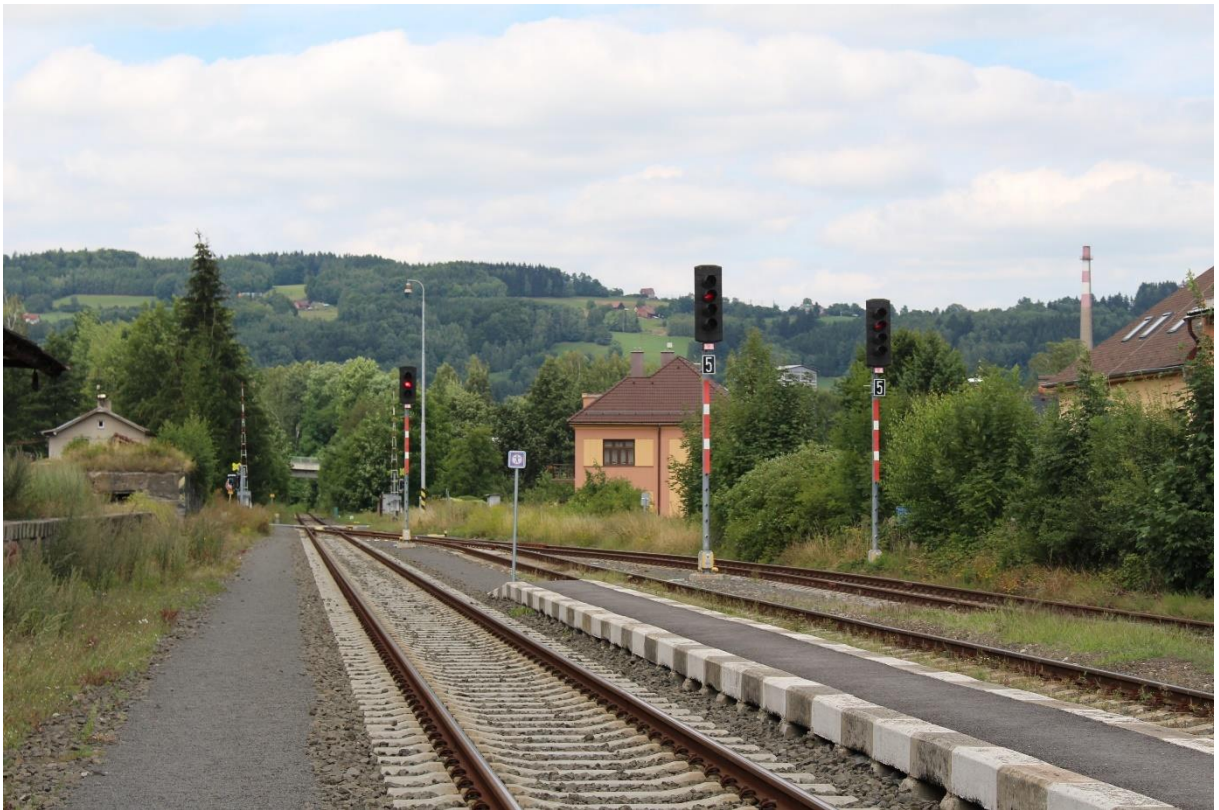
Odjezdová návěstidla ve směru Železný Brod
