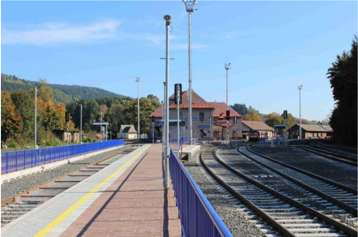
Obrázek 16 Železniční stanice Stará Paka po rekonstrukci
