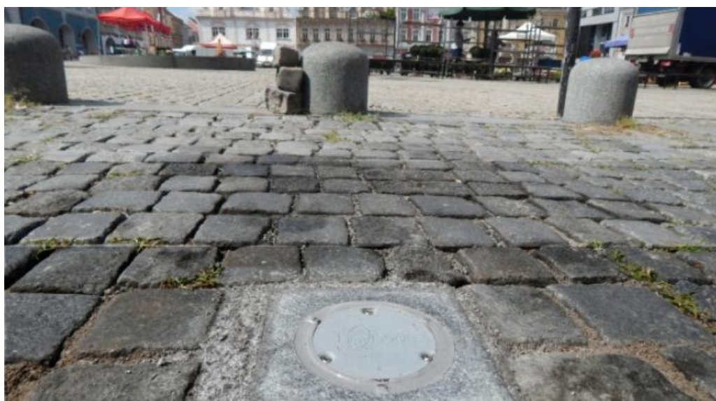
Obrázek 17: Zabudování senzorů do vozovky v Kolíně [22]
