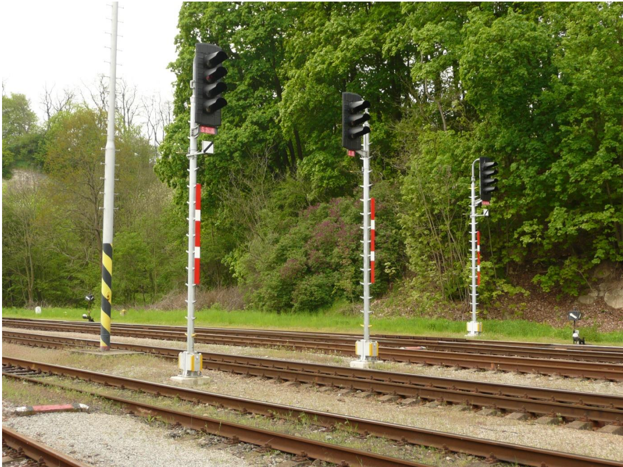
Obrázek 8: 2 Skupinová odjezdová návěstidla a 1 odjezdové na debřském zhlaví Zdroj: vlastní fotoarchiv, foceno 7. 5. 2017
