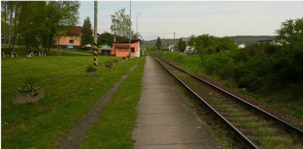
Obrázek 12: Pohled na prostor zastávky Malá Bělá
