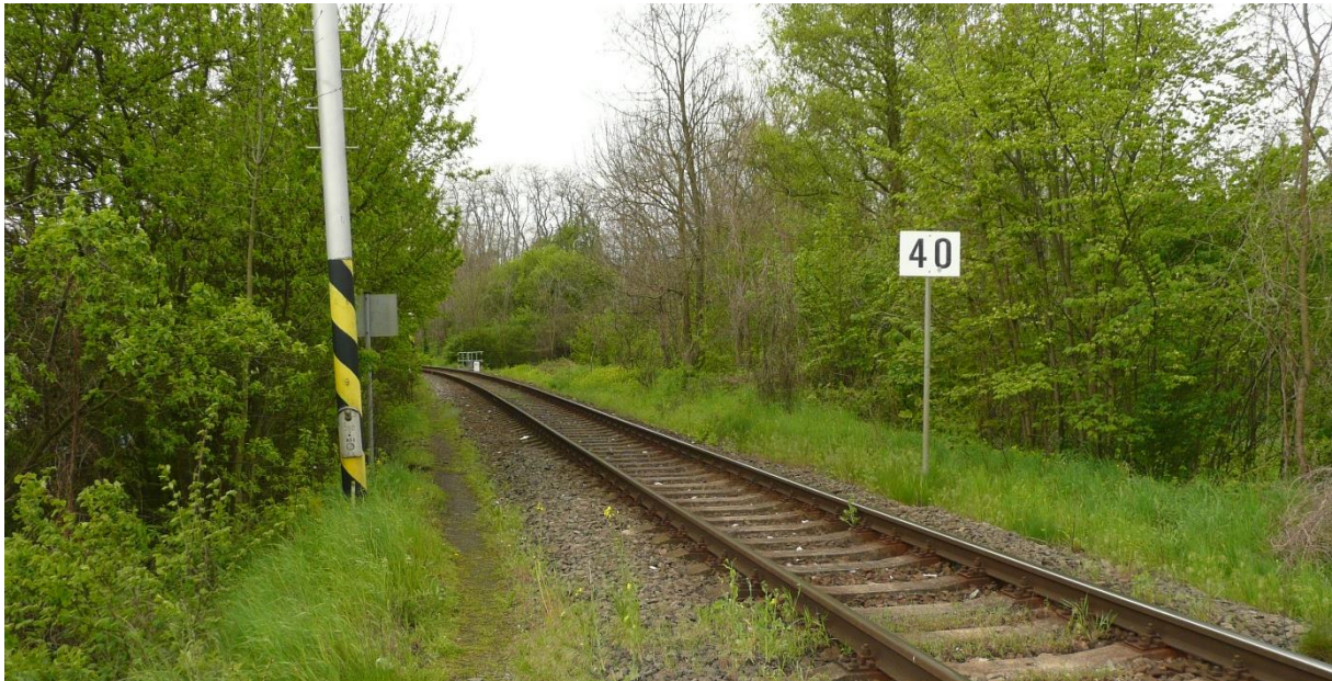
Obrázek 15: Pohled na traťovou rychlost 40 km/h na vjezdu ve směru od Turnova
