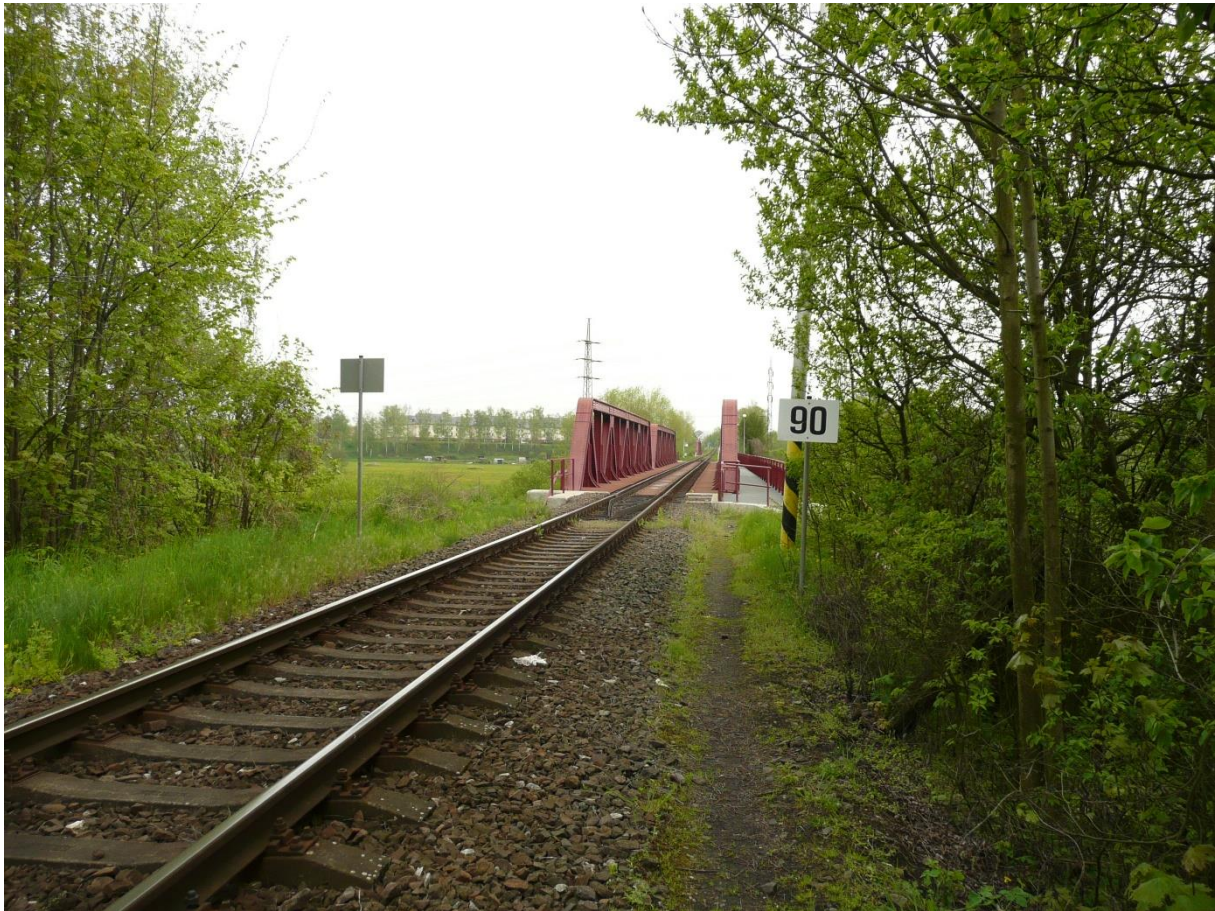
Obrázek 7: Traťová rychlost 90 km/h na trati 070 ve směru na Turnov za stanicí
