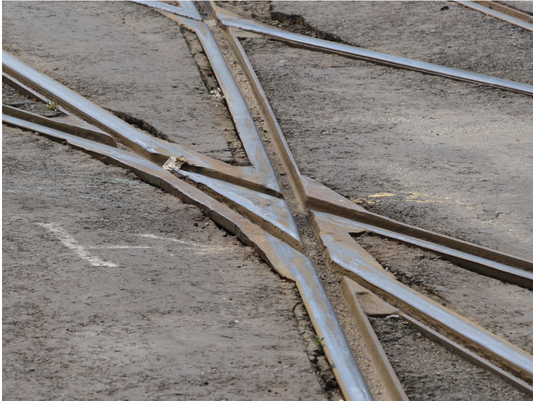
Obr. 24: Trojitá srdcovka atypického uspořádání ve dvojitě kolejové spojení úvratové konečné zastávce Határ út v Budapešti (8/2016, archiv J. Hradila).
