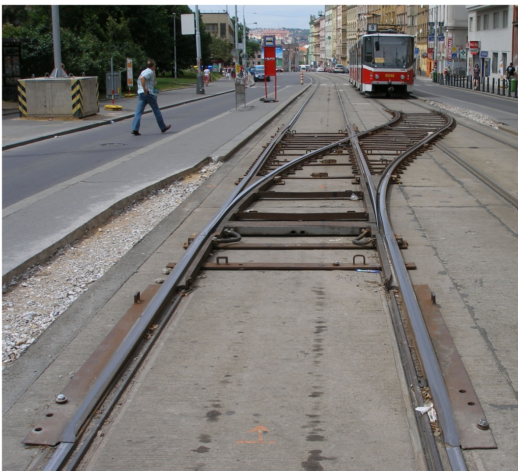
Obr. 10: Pohled na povrchovou kolejovou spojku Californien instalovanou při výluce v zastávce Husinecká (6/2008, archiv J. Hradila).
