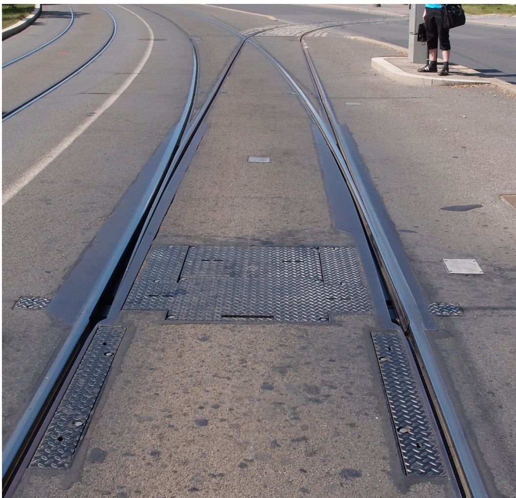
Obr. 19: Pohled na výhybku R02, kterou tvoří konvenční bloková výhybka o poloměru odbočení 150 m (8/2017, archiv J. Hradila).
