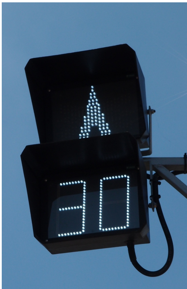
Obr. 17: Návěstidlo rychlostní výhybky R02 (8/2017, archiv J. Hradila).
