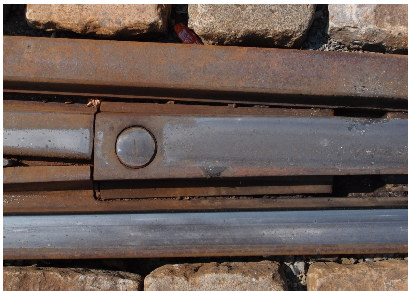
Obr. 3: Detail čepu, na kterém je upevněn jazyk výhybky. Na pravé straně je patrné místo, kam se vkládá stavěcí klíč. Výhybka se nachází v obratišti Nádraží Braník (8/2017, archiv J. Hradila).
