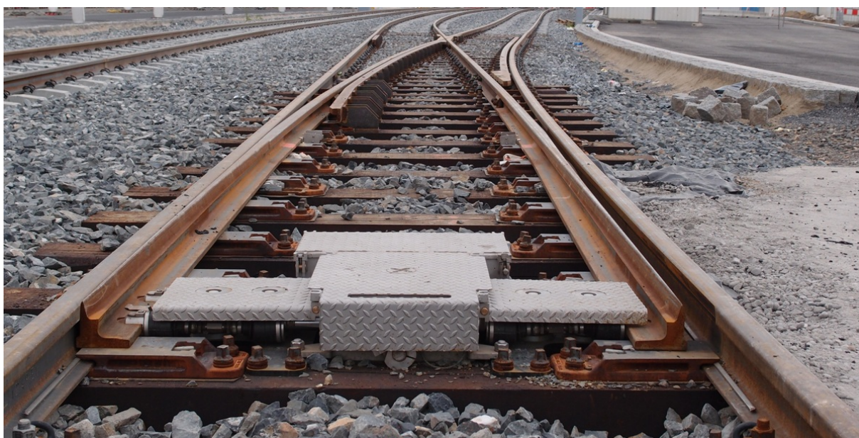
Obr. 18: Rychlostní výhybka R01 brzy po osazení na své místo, na snímku je patrná značná podobnost se železniční výhybkou. (7/2013, archiv J. Hradila).
