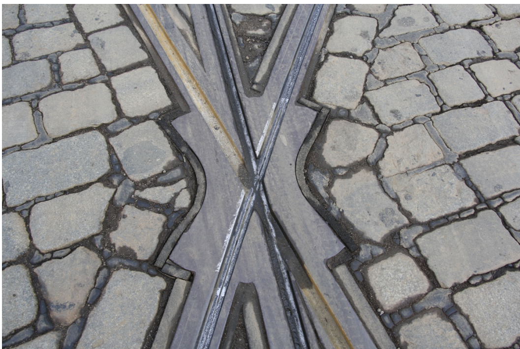
Obr. 23: Trojitá srdcovka na pražské křižovatce Palmovka (4/2016, archiv J. Hradila).
