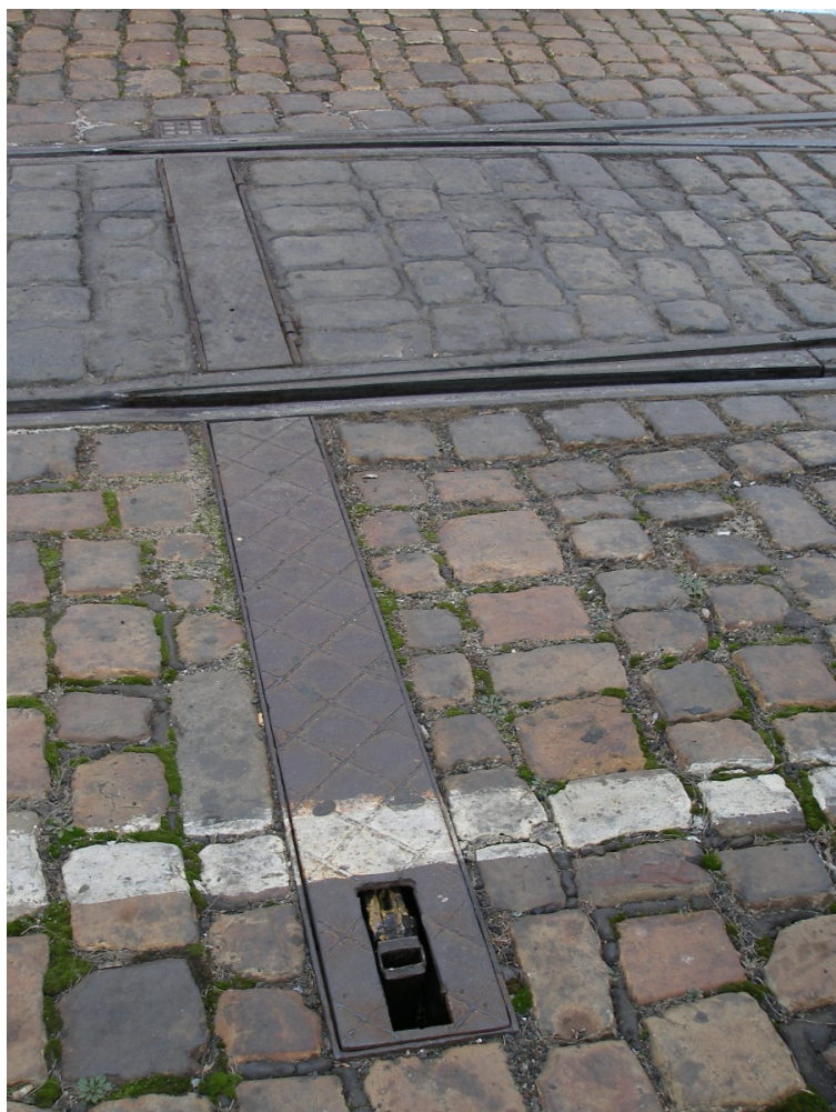
Obr. 9: Zajišťovací čepová výhybka s vyvedeným táhlem, kterým je možné výhybku dočasně „podržet“ přestavenou do běžně nepojížděného směru. Výhybka se nachází na dvoře vozovny Střešovice (11/2008, archiv J. Hradila).
