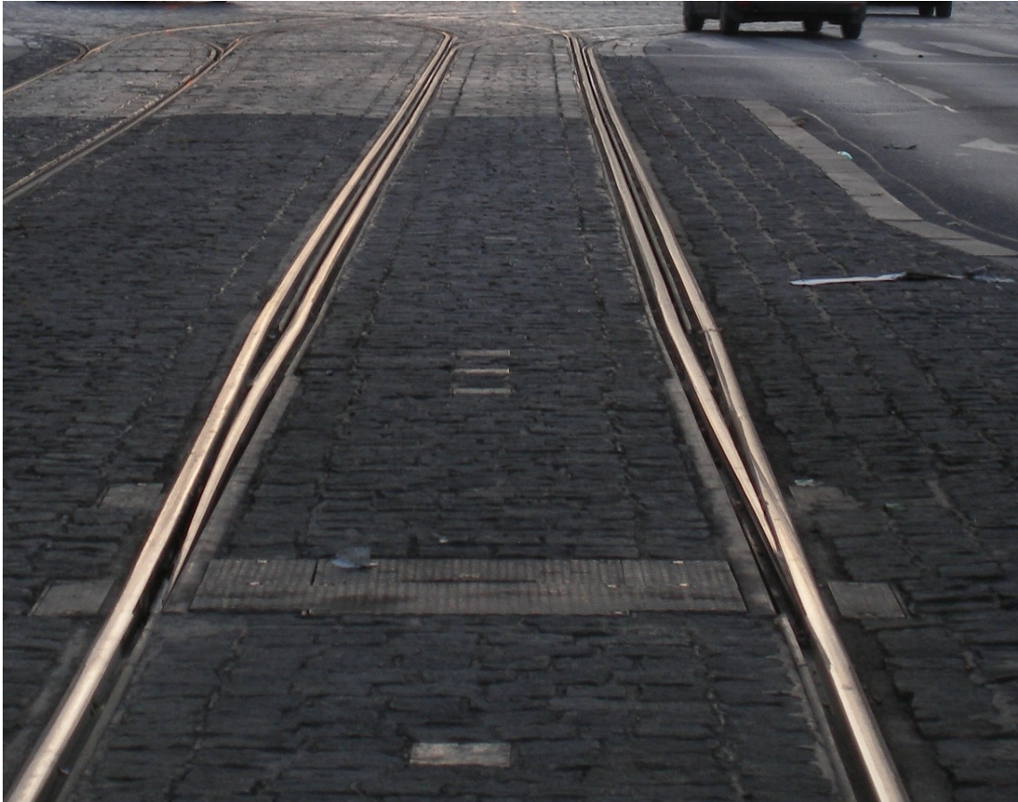
Obr. 26: Štíhlá výhybka za zastávkou Ohrada, za kterou začíná rozřazovací kolejová splítka s jednosměrným provozem (12/2008, archiv J. Hradila).
