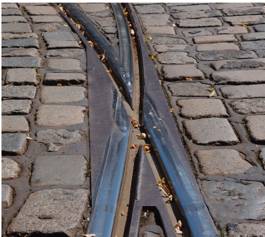
Obr. 22: Bloková ocelová srdcovka ve výhybce v obratišti Olšanské hřbitovy (8/2016, archiv J. Hradila).
