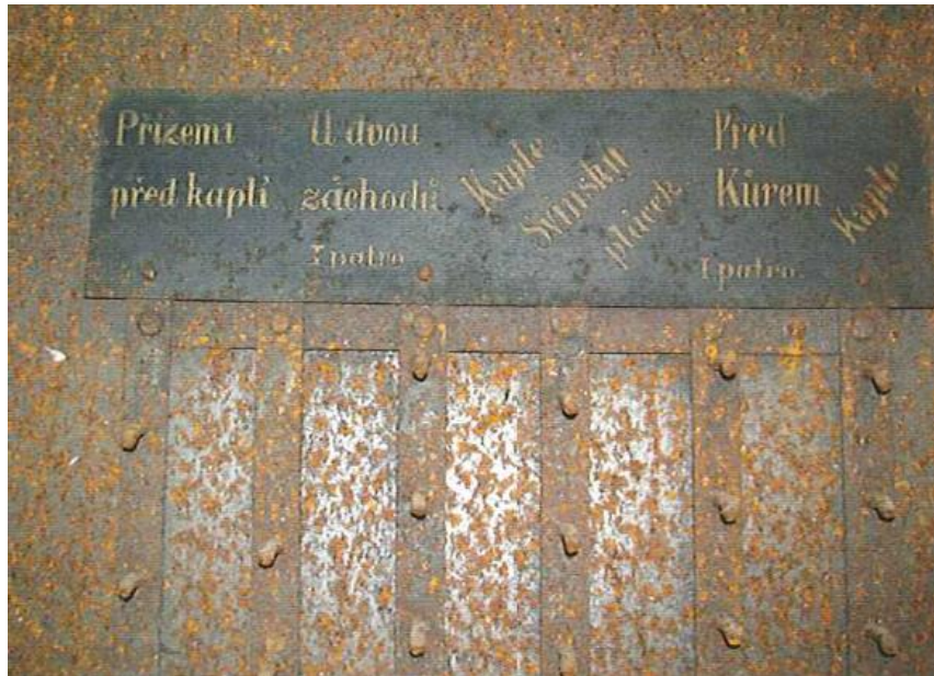
Obrázek 17 Ovládací klapky pro jednotlivé místnosti bez ocelových lanek (zámek Hluboká nad Vltavou) [13]
