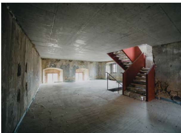
necitlivě vložený železo- betonový strop v jižní části hradů. Deska tvoří mezipa- tro v úrovni oken a tím je přerušuje. Návrh počítá s odstranění této konstrukce a vytvo- ření převýšeného prostoru pro výtvarný ateliér.
