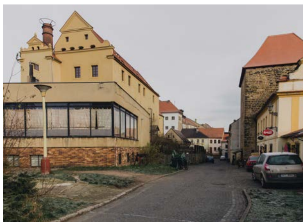
Pohled na stávající objekt kulturního domu z hrany hradeb. Patrné jsou nevhodné materiály a tvarosloví fasády nekorespondující s okolní zástavbou.
