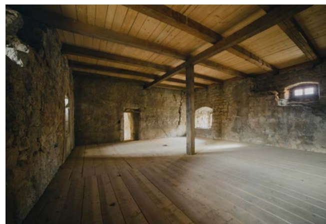
necitlivě vložený železo- betonový strop v jižní části hradů. Deska tvoří mezipa- tro v úrovni oken a tím je přerušuje. Návrh počítá s odstranění této konstrukce a vytvo- ření převýšeného prostoru pro výtvarný ateliér.
