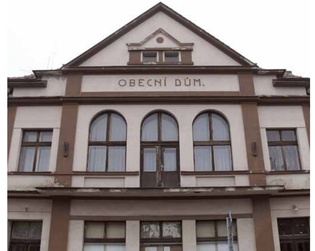
Tympanon objektu nad středním traktem jižního křídla ▲
