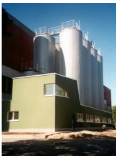
Obr. 4 CKT Pivovar Ragutis, Litva ( http://www.aedproject.cz )
