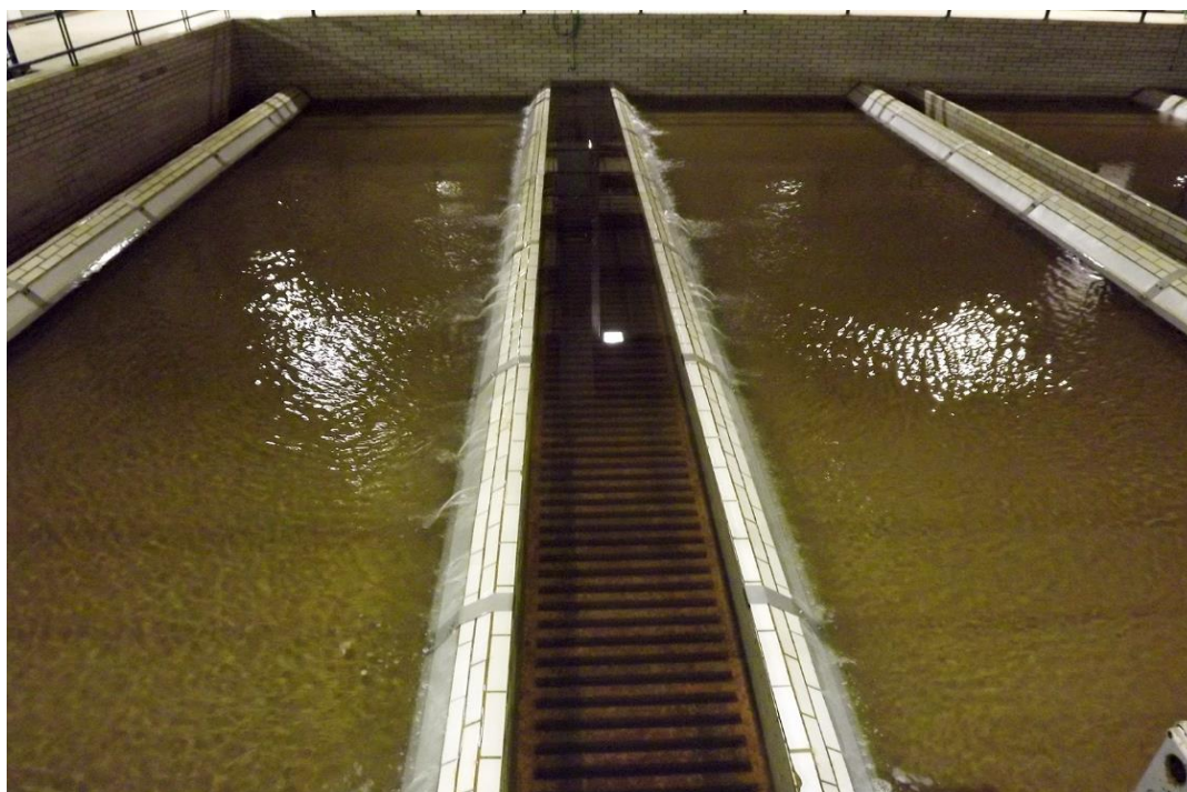
Obr. 20: Evropský typ filtru (dvě filtrační pole)
