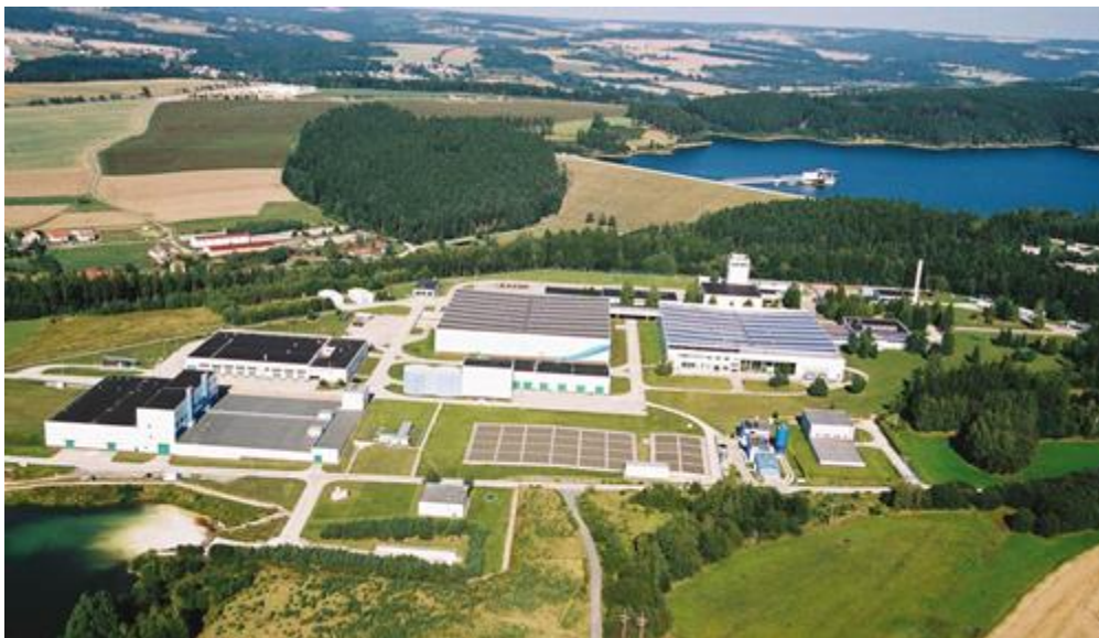
Obr. 9: Areál Úpravní pitné vody Želivka
