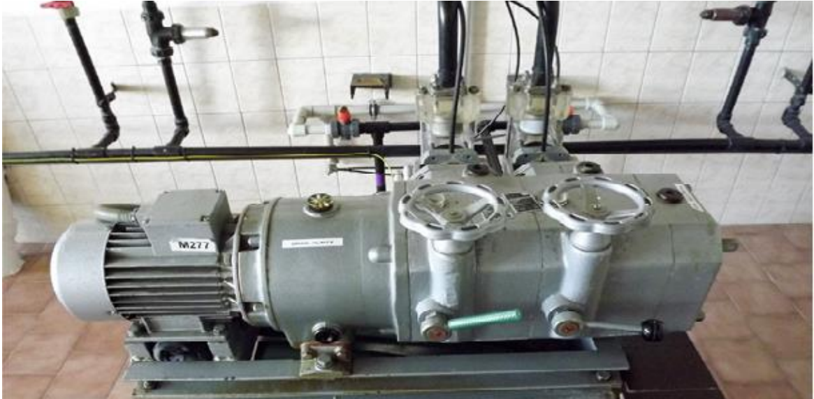
Obr. 14: Dávkoč roztoku síranu hlinitého
