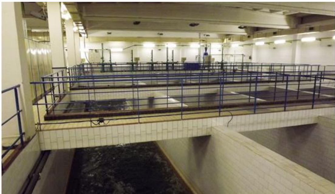
Obr. 15: Flokulační nádrž (meandr)
