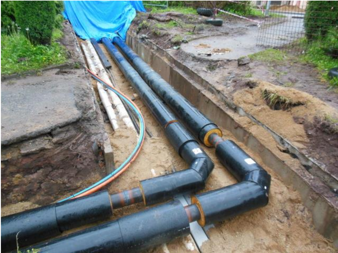
Obrázek 5 – Příklad vedení teplovodní sítě (podzemní bezkanálový systém)
