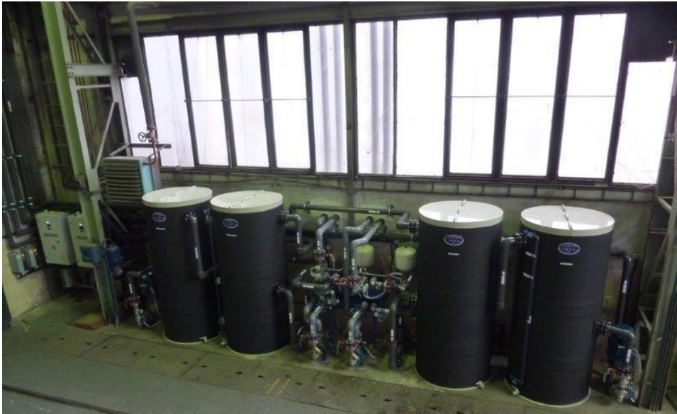
Obrázek 8 – Ukázka akumulace energie ve vodě v průmyslovém provozu
