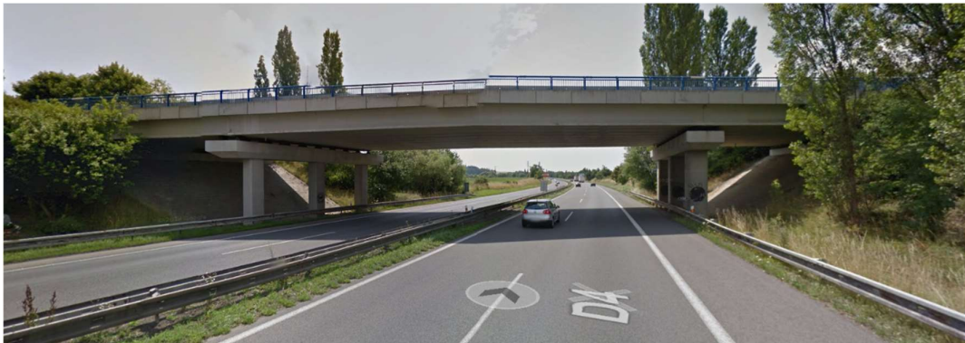
Obr. 3.13 Ukázka použití pilířů s roznášecími příčnicími. Mostní objekt: 11418-1 Zdroj: [15] D4, Dlouhá Lhota
