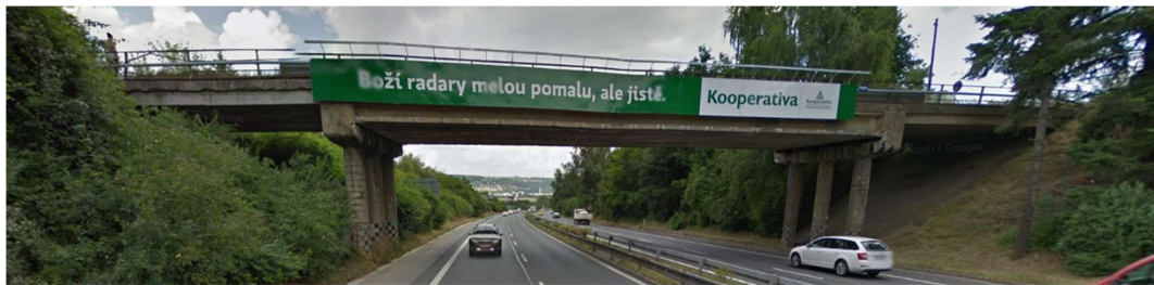
Obr. 3.2 Nadjezd K Výtopně x D4, ukázka rozdílných výšek nosníků Zdroj: [15] D4
