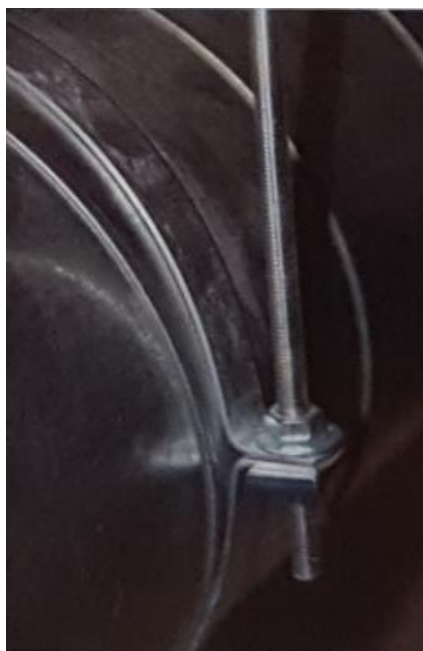
Obrázek 4: Potrubní závěs [3]
