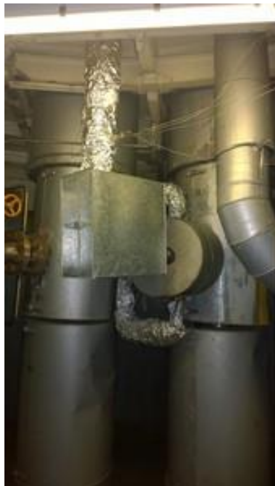
Obrázek 11: Izolovaná trubka s hliníkovou fólií
