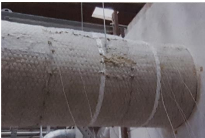
Obrázek 5: Izolace bez kotvení trny [3]
