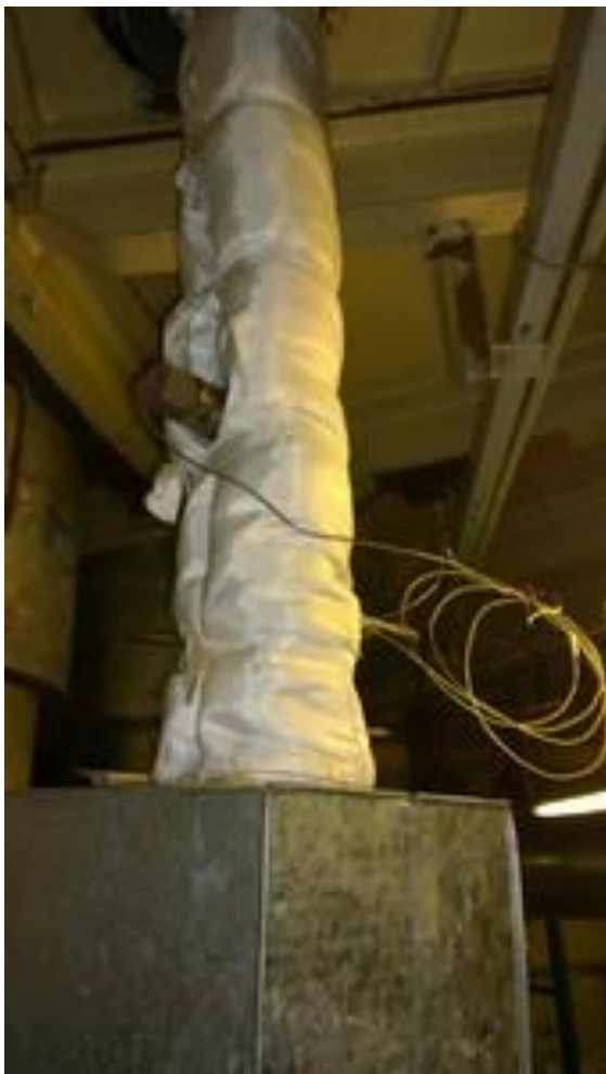
Obrázek 12: Izolovaná trubka bez pokrytí
