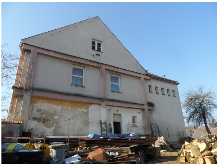
Obr.20: Pohled ze dvora (zdroj: vlastní foto)
