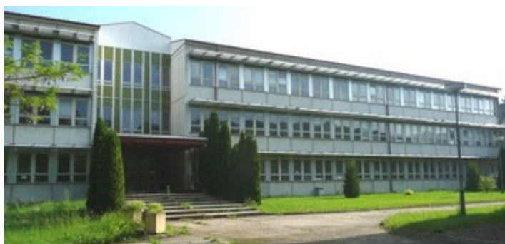
Obr.1: Stav před rekonstrukcí (zdroj: www.bydletvpanelu.cz )
