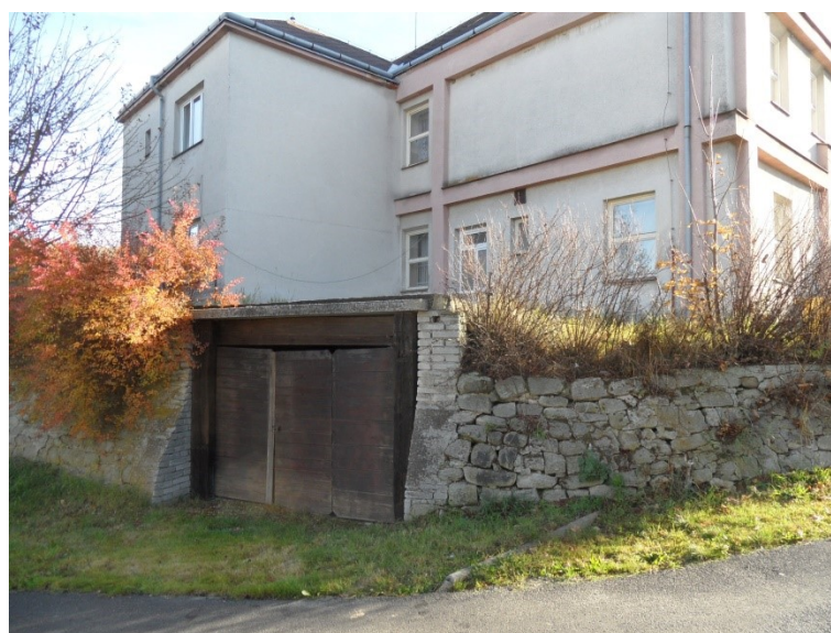
Obr.19: Pohled na přilehlou garáž (zdroj: vlastní foto)
