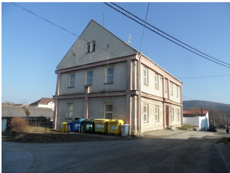
Obr.18: Jižní pohled (zdroj: vlastní foto)
