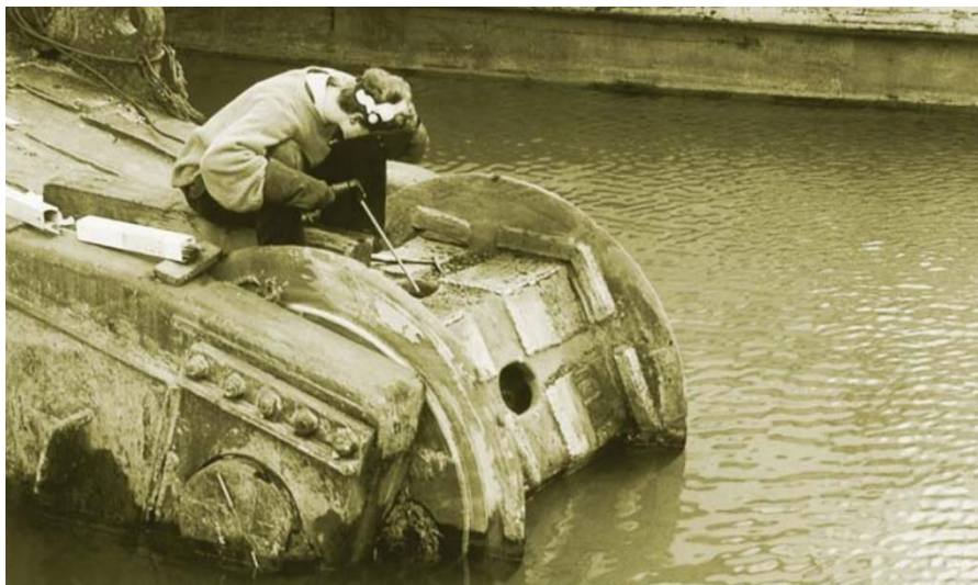
Obrázek 1. Navařování kladky bagru elektrodou [36]
