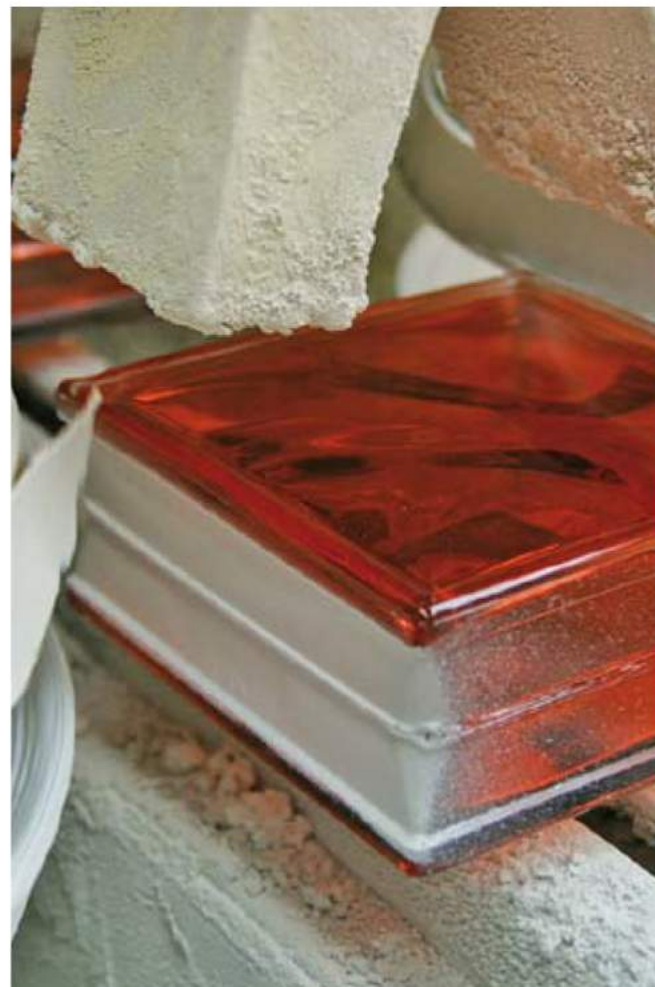
Nanášení latexu na tvárnice
