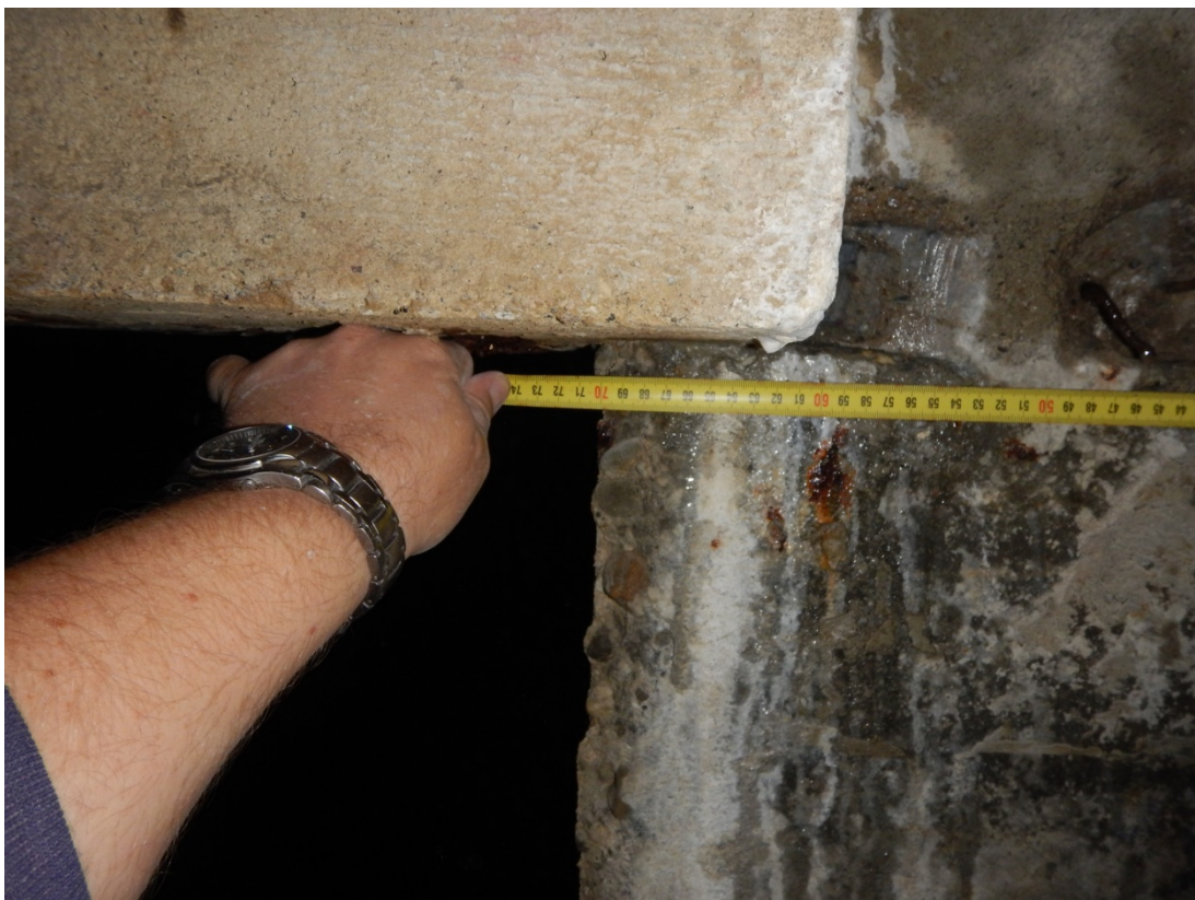
Obr.42 Vodojem Severomoravský kraj 2017
