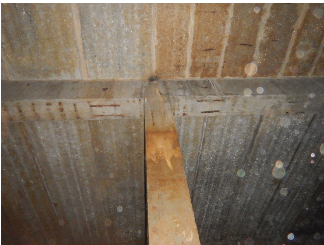
Obr.39 Vodojem Severomoravský kraj 2017
