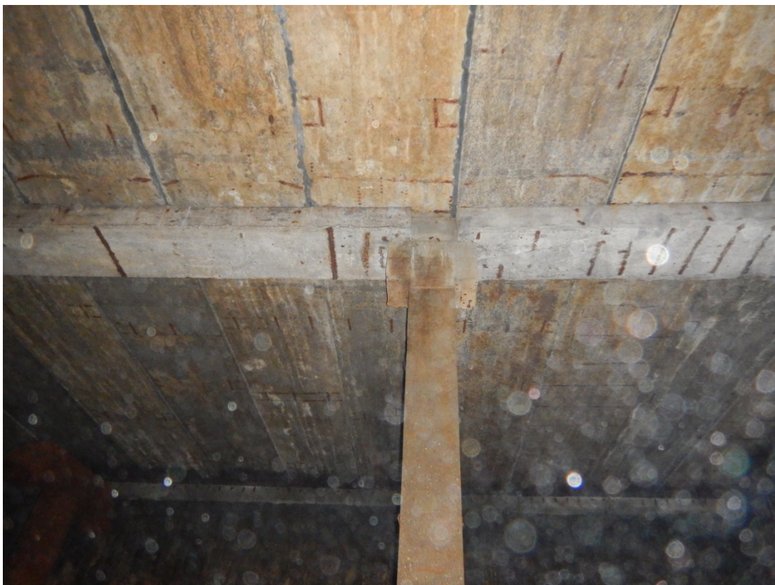
Obr.40 Vodojem Severomoravský kraj 2017
