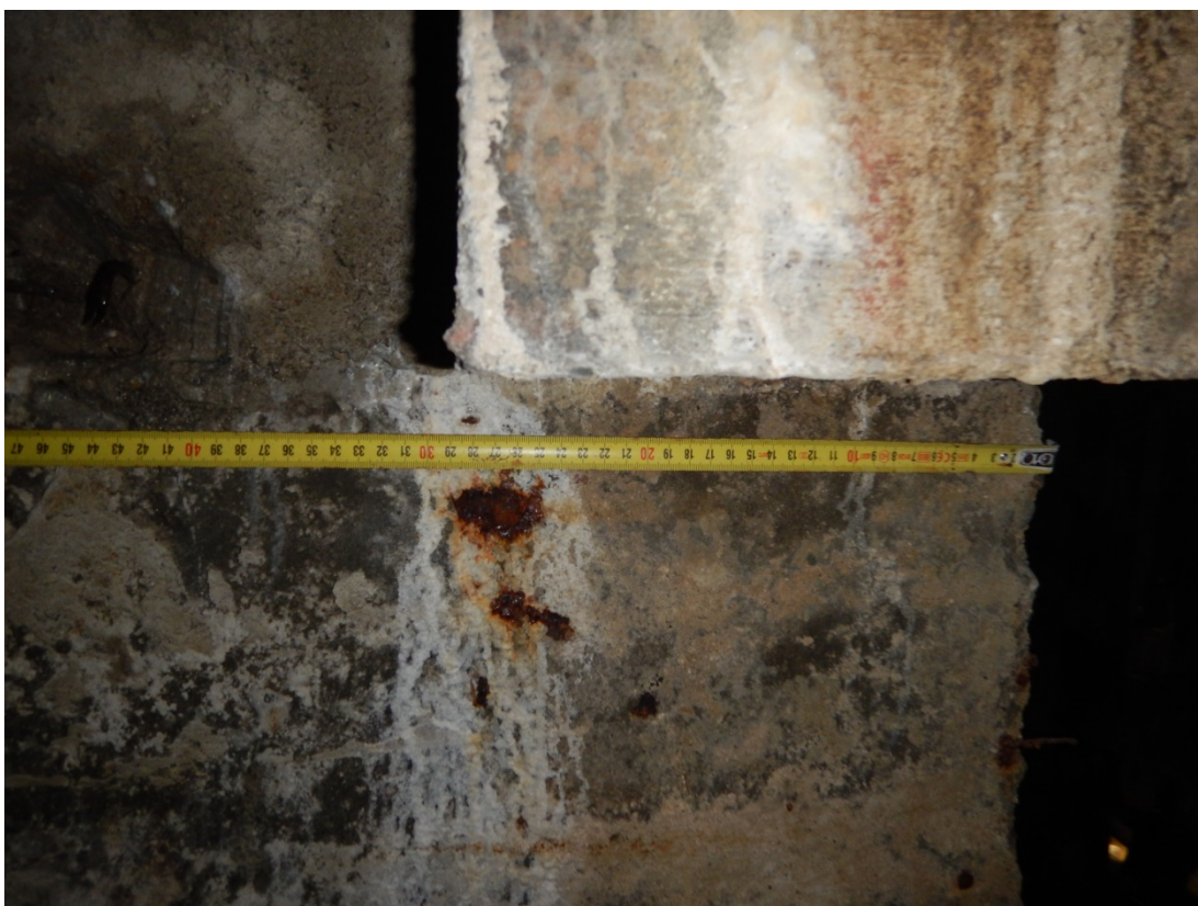
Obr.43 Vodojem Severomoravský kraj 2017
