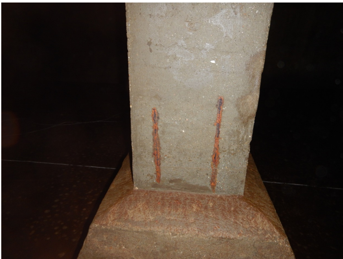
Obr.38 Vodojem Severomoravský kraj 2017
