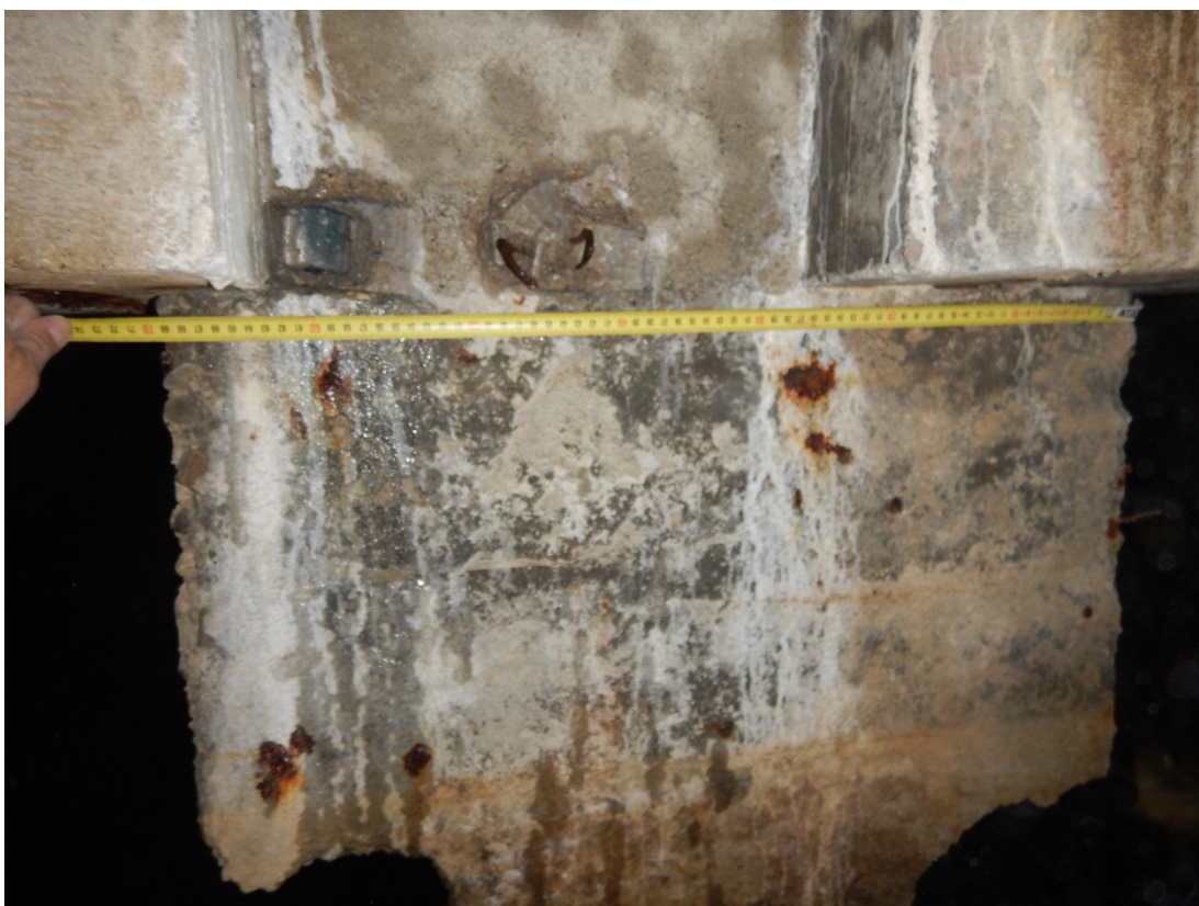
Obr.41 Vodojem Severomoravský kraj 2017
