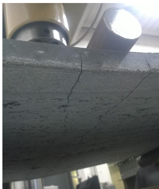
Obr. 85: Porušení betonu v tahu deska D1 [29]
