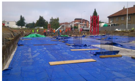
Obr. 32: Zakrytí betonu fólií [38]
