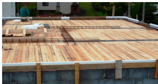
Obr. 30: Dřevěné bednění stropní kece [36]
