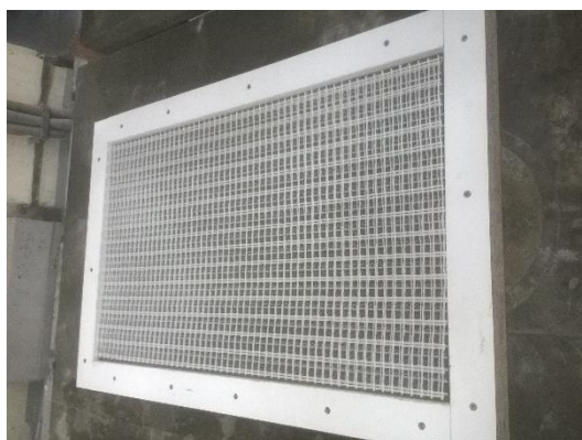
Obr. 69: Vložení sítě – vodorovná betonáž [29]
