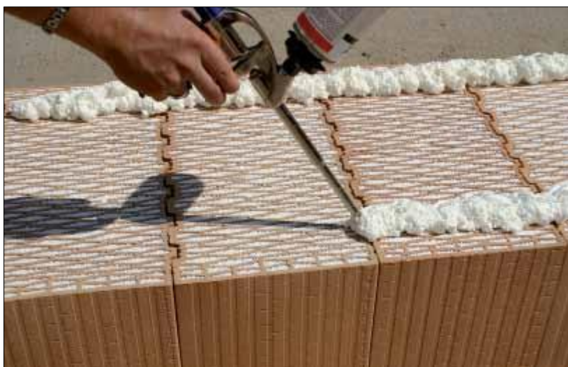
OBRÁZEK 17: SYSTÉM P+D, NANÁŠENÍ MONTÁŽNÍ PĚNY [26]
