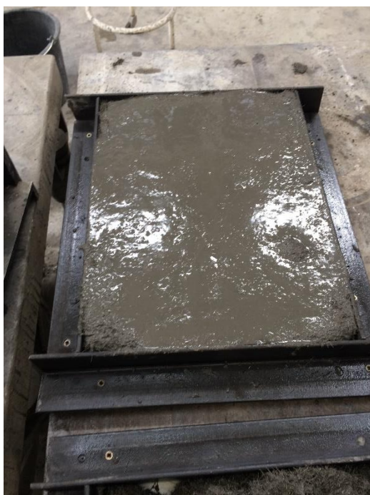
Obrázek 13: Betonová směs se 4,7 % zastoupením ocelových vláken po zhuštění a zavibrování.
