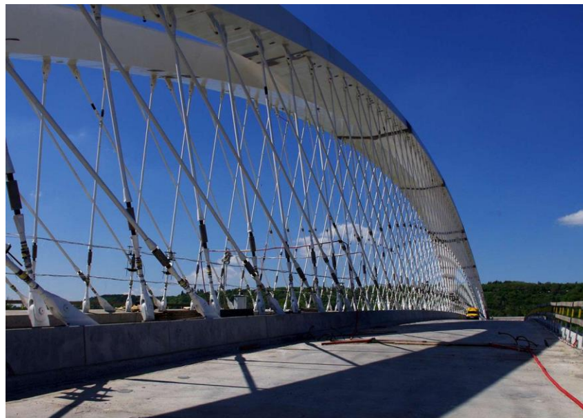
Obr. 1.36 Pohled na táhla Trojského mostu [6]
