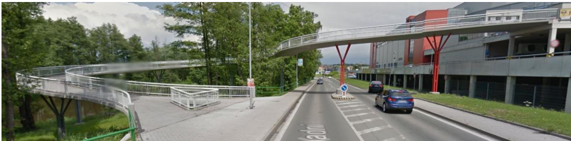
Obr. 2.01 Lávka u KV Areny (Karlovy Vary) [9]
