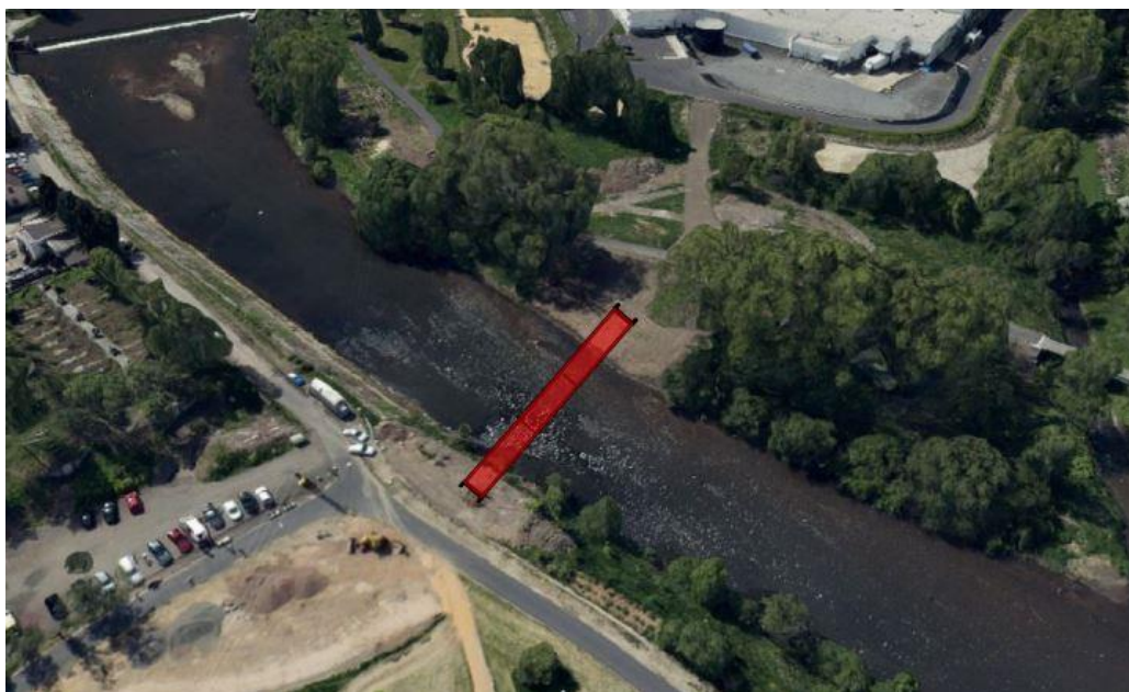
Obr. 2.2.1 Pohled na místo stavby [7]
