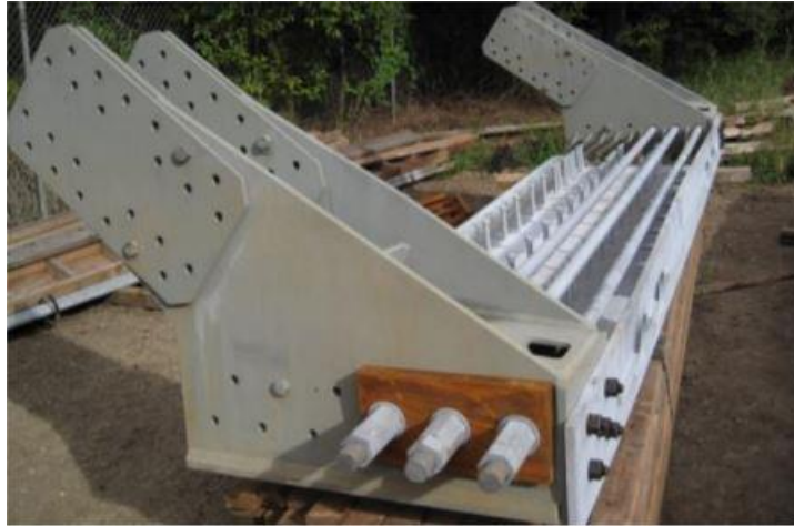
Obr. 1.39 Pohled na ocelový příčník [11]
