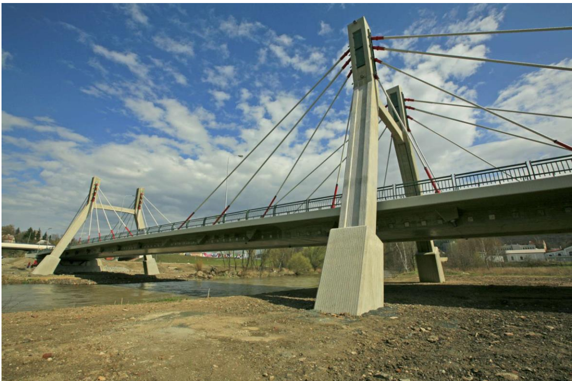
Obr. 2.02 Zavěšený most přes řeku Ohře [12]
