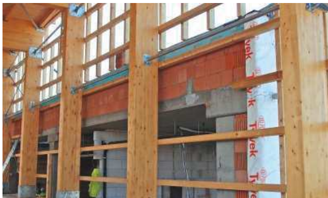
Obr. 5 Dřevěný vetknutý sloup z lepeného dřeva (10)
