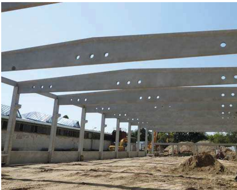
Obr. 1 Vazníková hala bez tenkostěnných vaznic (4)
