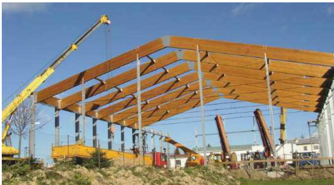
Obr. 7 Hala z kombinace ocelových a dřevěných prvků (14)
