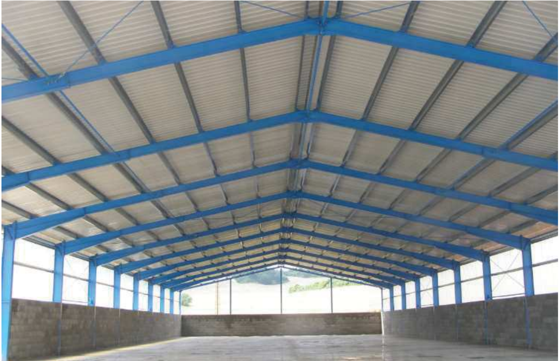
Obr. 6 Typická ocelová rámová konstrukce s tenkostěnnými vaznicemi (13)
