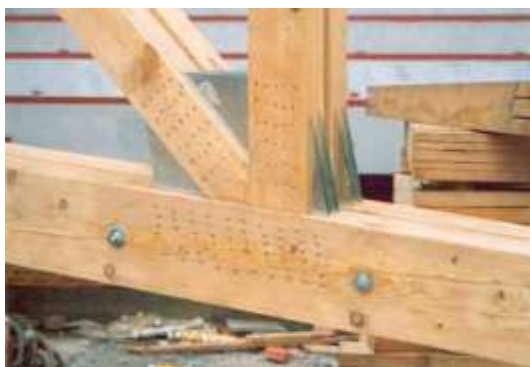
Obr. 3 Vložené styčnickové plechy (6)
