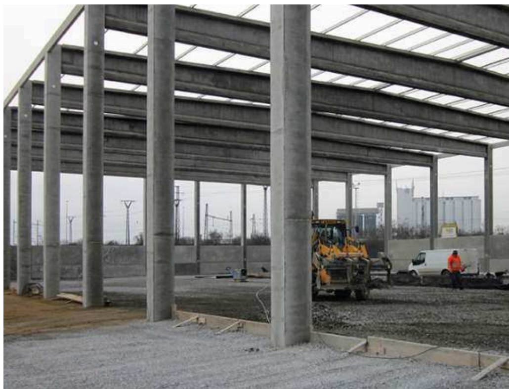
Obr. 1 Vazníková hala bez tenkostěnných vaznic (4)
